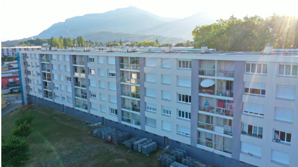
Les travaux terminés
