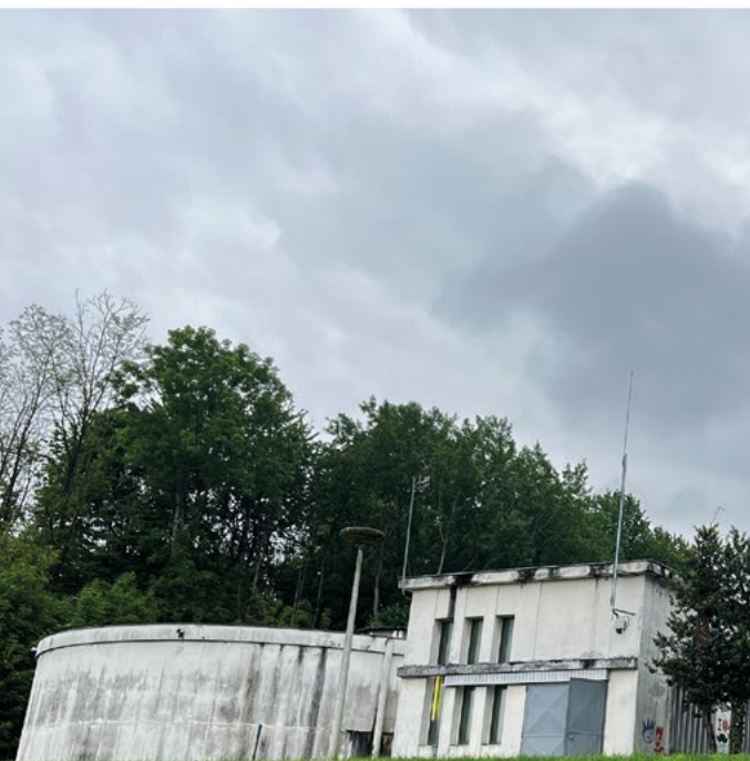
Réservoirs d'eau potable de la Bataillarde à Chambéry
