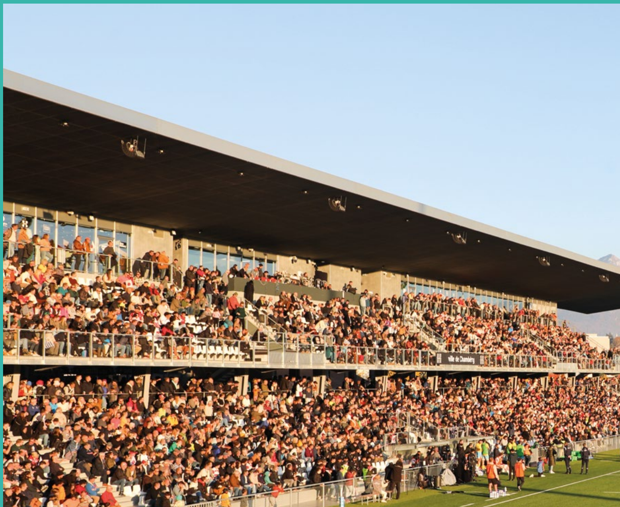
Les panneaux photovoltaïques seront installés sur les toitures des tribunes du stade.
