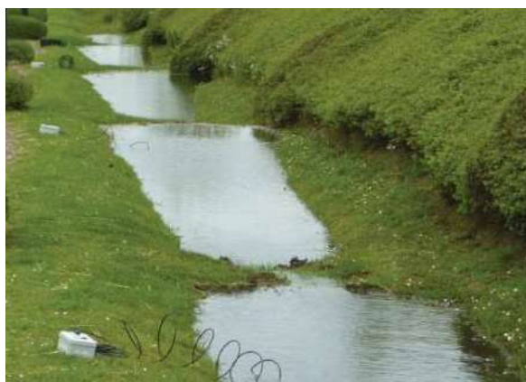
Exemple de dispositifs « en cascade » (source : AREAS)
