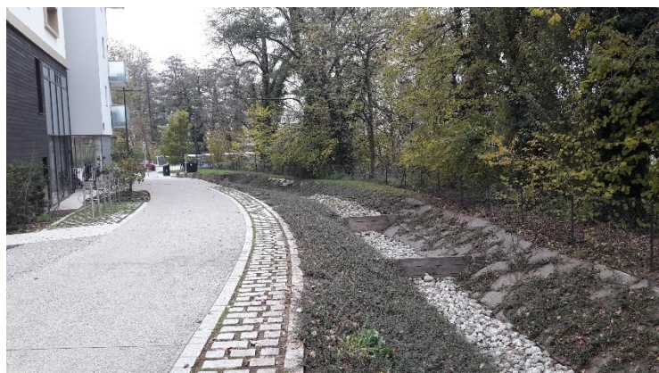
Exemple de dispositifs de rétention « en cascade »
