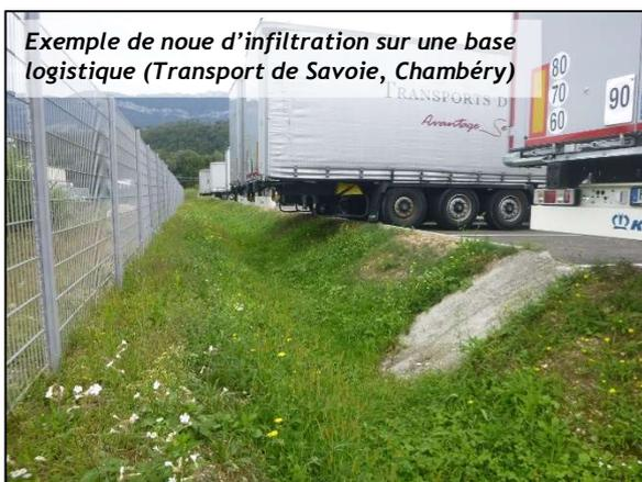
Exemple de noue d’infiltration sur une base logistique (Transport de Savoie, Chambéry)
