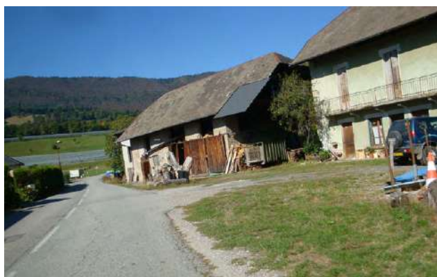
Ferme du versant de l'Épine avec une distinction du bâtiment d'exploitation de l'habitat, La Motte-Servoix
