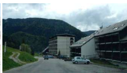
Parkings des résidences touristiques, Aillon-Station
