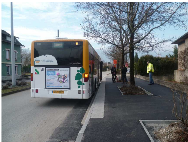
Arrêt Parc Relais Maison Brûlée – commune de Sonnaz
