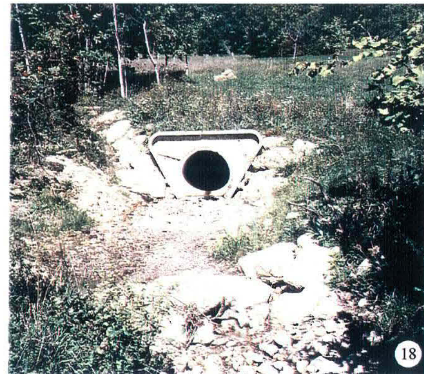
Enrochement du lit à proximité des captages d'eau potable et aperçu du passage busé ramenant les eaux dans le cours naturel.
