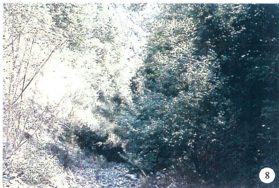
Tourne para-blocs de Montbasin. Partie aval. Etat en août 2000
