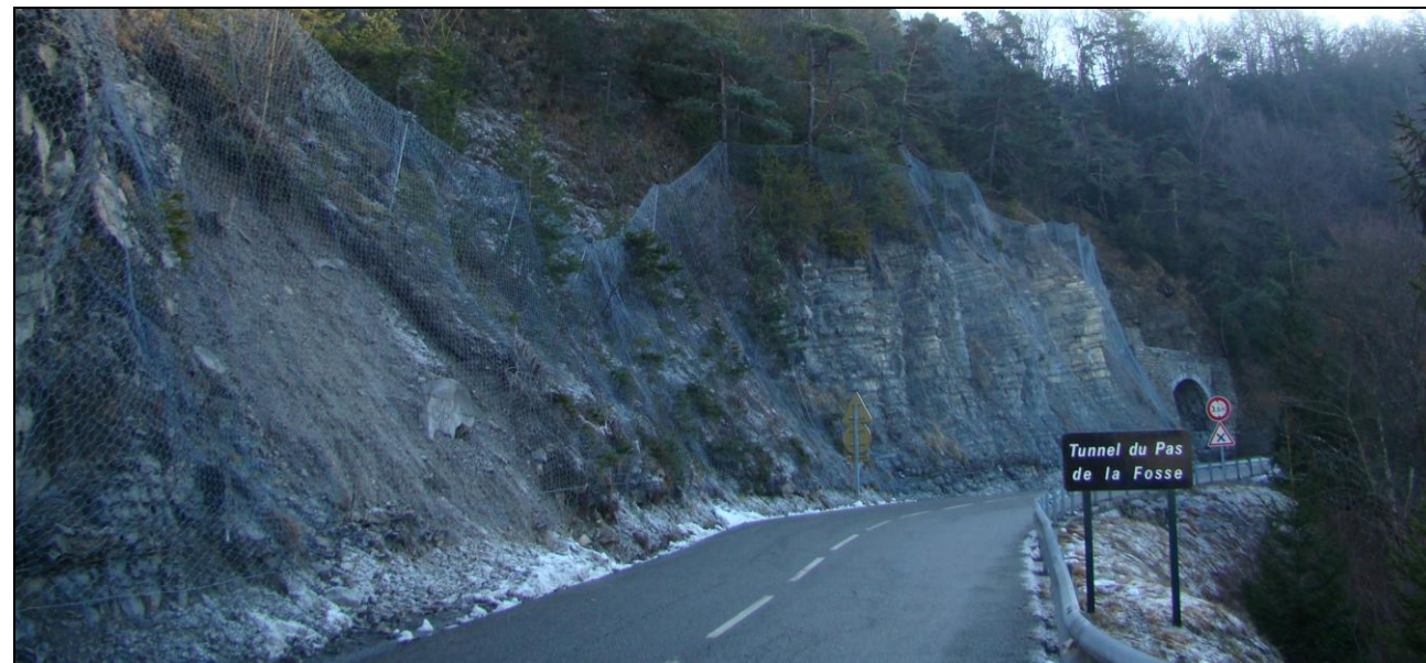
Figure 23 : Affleurements confortés le long de la RD 912 [Source : IMS RN ]
