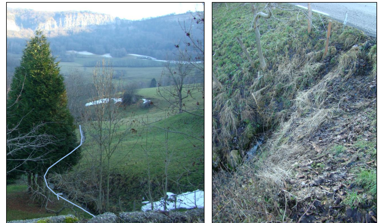
Figure 39 : Torrent affluent en rive gauche du Nant du Vard, aux Meuniers [Source : IMS RN ]
