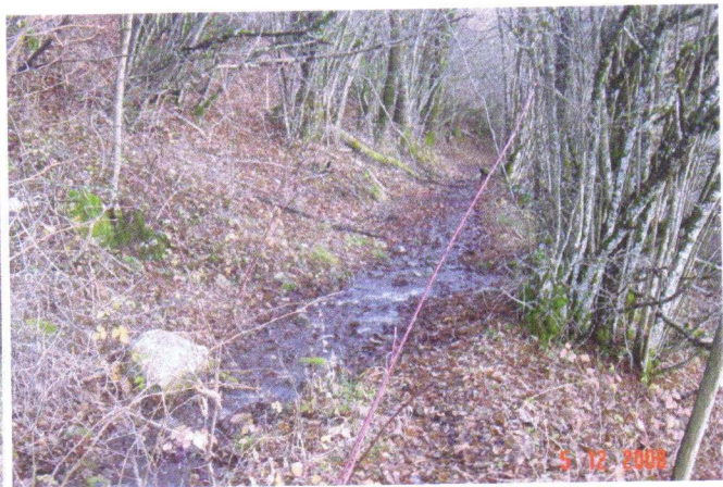
Bloc et venues d'eau sur le chemin rural
