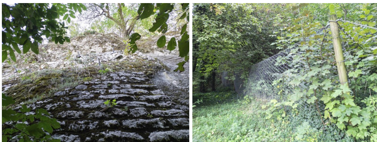
Vue des protections : confortements actifs et écran grillagé
