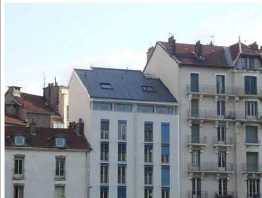
La nouvelle construction doit s'insérer harmonieusement dans le vélum des toitures environnantes. Grenoble
