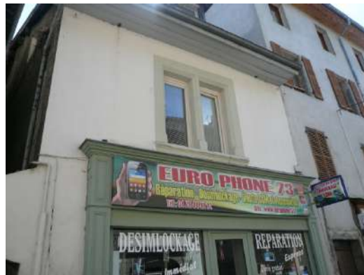
Faubourg Montmélian, fenêtre à meneau
