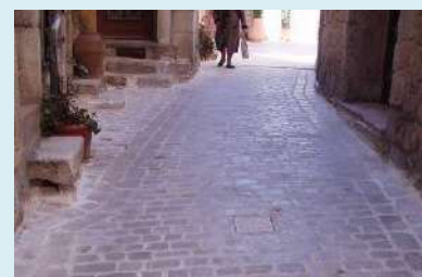
Pavés rejointoyés au mortier de chaux avec bandeaux latéraux
