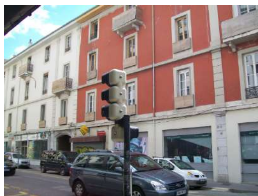
Rue Sommeiller, murs en pierres de blocage enduits
