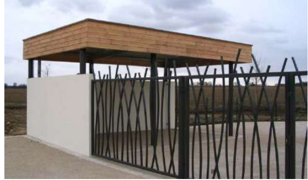
Garage à vélos aménagé pour la biodiversité Toiture végétalisée, pose de nichoirs
