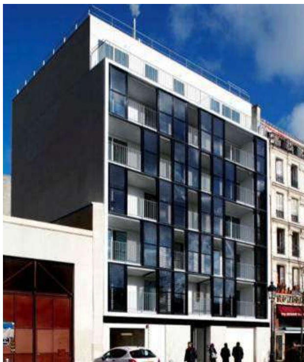
Agence Filippo- Kalt : immeuble de logements, Paris, avec vitrage isolant + capteur thermique (ECS) en façade
