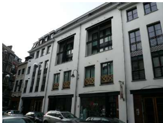
Bruxelles, immeubles neufs dans un tissu urbain ancien. Diversité des ouvertures.
