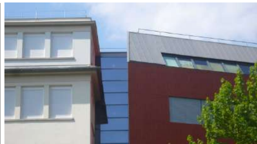
Strasbourg, toiture à versants
