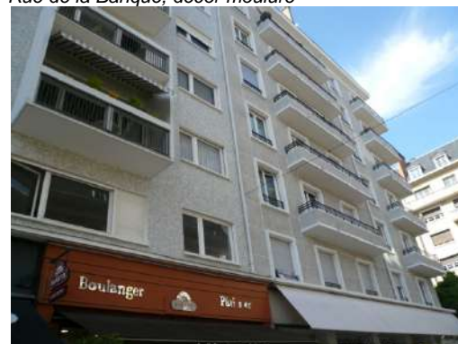
Rue Berthollet, exemple de décor 20 ème siècle : modénature simple, revêtement en pâte de verre
