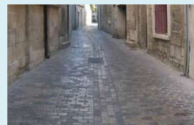
Pavés rejointoyés avec caniveau central avec bandeaux latéraux
