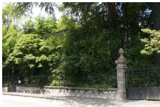
Clôture Clos Savoiroux
