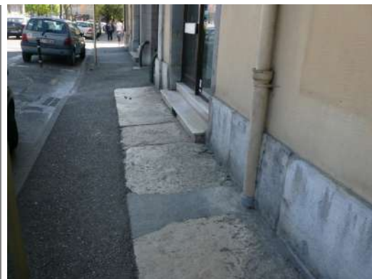
Seuils en pierre, avenue de Lyon
