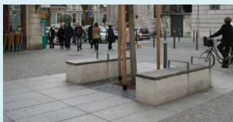
Dalles et pavés granit - Les Halles (Chambéry)
