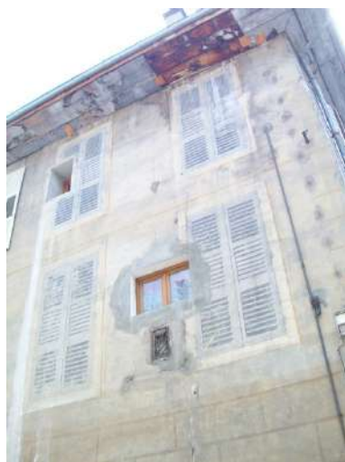
Façade en trompe l'œil (altérée)
