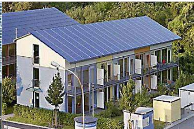
Panneaux photovoltaïques sur la totalité d'un versant
