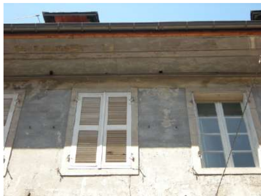
Passée de toit caissonnée
