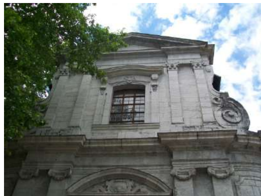
Chapelle du Lycée, pierres appareillées
