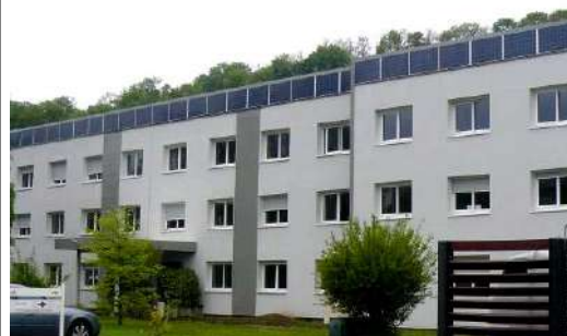
Aix les Bains, l'acrotère est traité comme un couronnement, en panneaux photovoltaïques.
