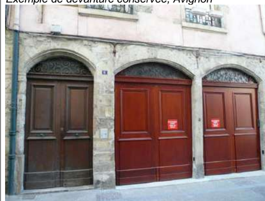
Transformation en garage, respect de la forme de l'ouverture, Vienne.
