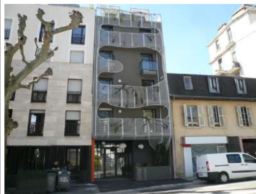
Aix les Bains, double peau en résille métallique
