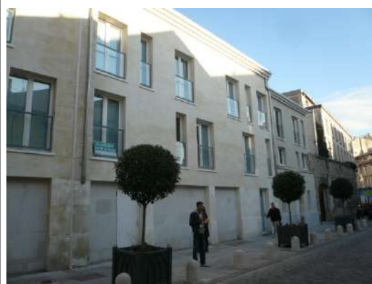
Avignon, immeuble neuf, façade en pierres agrafées, mur ventilé
