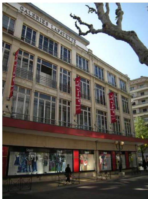
Boulevard de la Colonne, belle unité des vitrines
