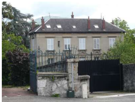
Clôture Clos Savoiroux
