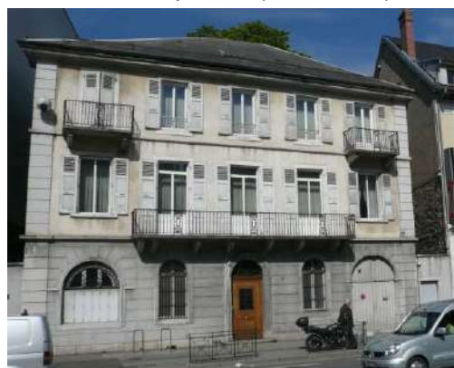
Avenue des Ducs de Savoie, soubassement en pierre de taille
