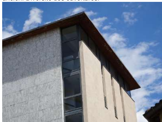
Vienne, ouvertures longitudinales
