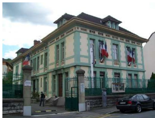
Rue Pasteur, immeuble fin XIXème siècle- début XXème siècle
