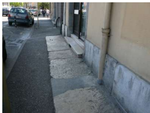
Seuils en pierre, avenue de Lyon
