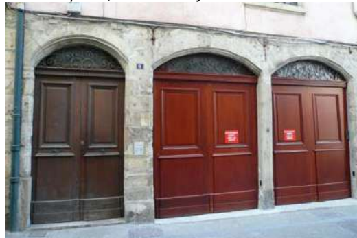
Transformation en garage, respect de l'ouverture, Vienne
