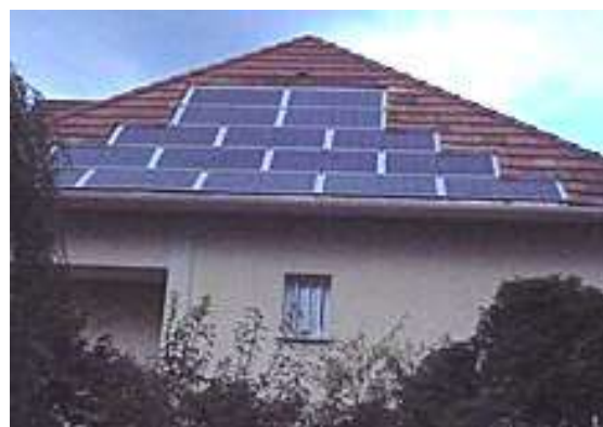
Pas d'adéquation avec la forme, effet de carreaux renforcé par la structure apparente.
