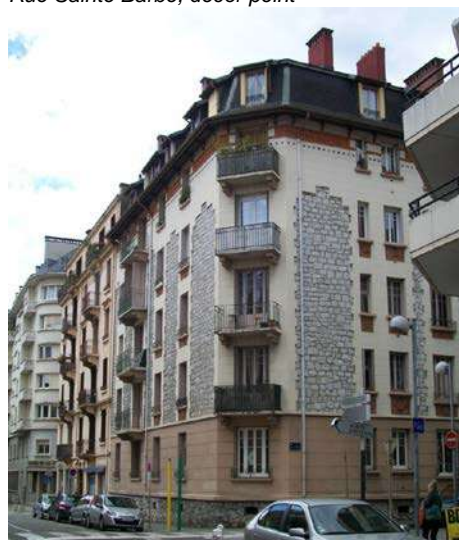
Rue Victor Hugo, décor début 20 ème siècle avec matériaux mixtes, dont pierre en plaquage rustique.
