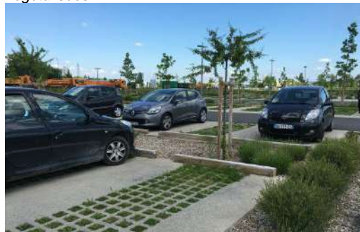
Exemples Aménagements aires de stationnement végétalisées
