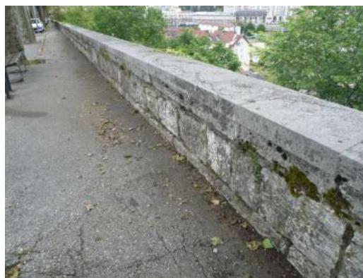
Mur protégé Faubourg Reclus
