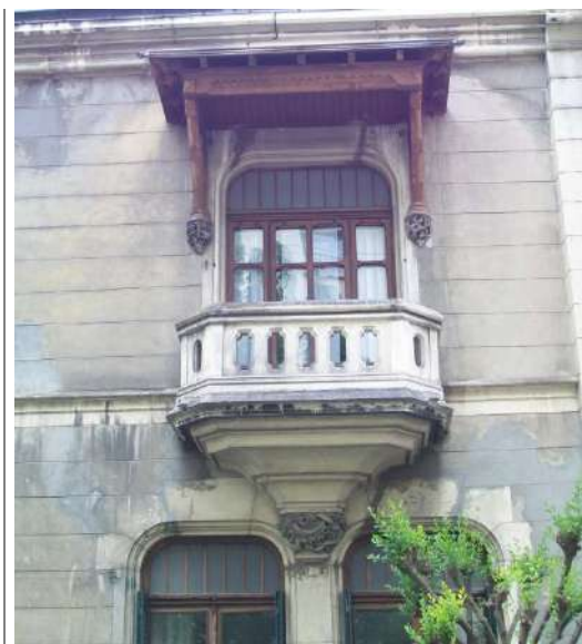
Rue Marcoz, menuiseries anciennes à conserver
