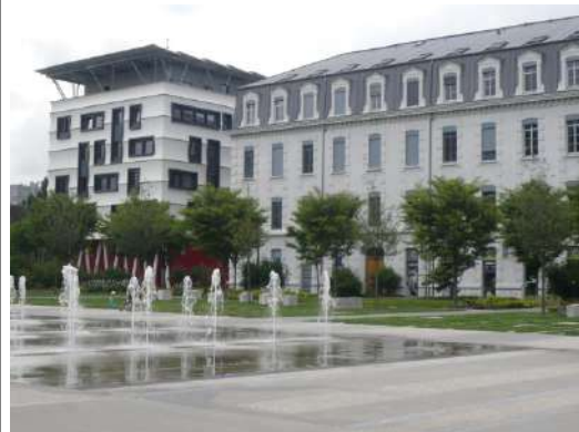
Grenoble, Caserne de Bonne, bâtiment à énergie positive
