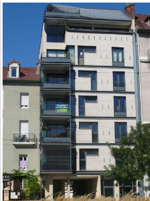
Grenoble, toiture à versants
