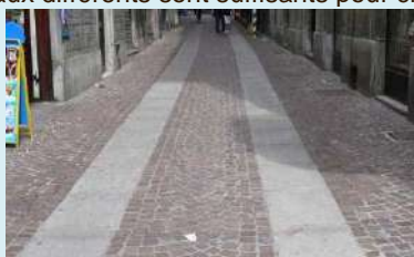
Pavés de Porphyre pour l'ensemble de la rue et dalle de pierre pour les bandes de roulement (Chieri, Italie)
