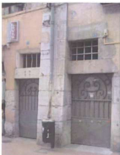
Glacis des contreforts et porte en accolade du 16 e siècle
