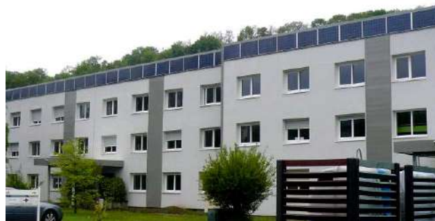
Aix les Bains : bureaux de la CALB, l'acrotère est traité comme un couronnement, en panneaux photovoltaïques.
