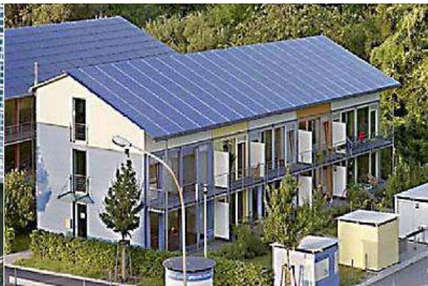
Panneaux photovoltaïques sur la totalité d'un versant
