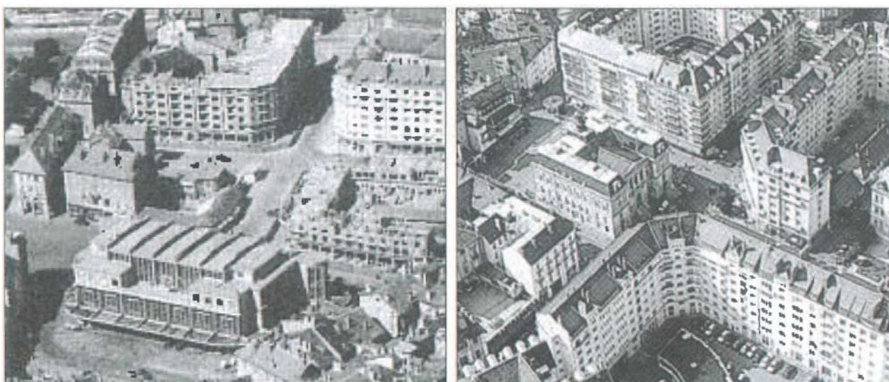
La Reconstruction en cours
