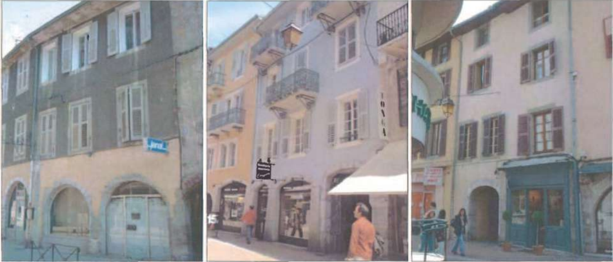
Maisons du 19 e siècle sur des vestiges anciens
