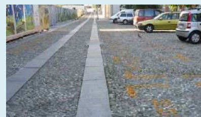
Calade pour l'ensemble de la rue et dalles de granit pour les bandes de roulement (Turin, Italie)
