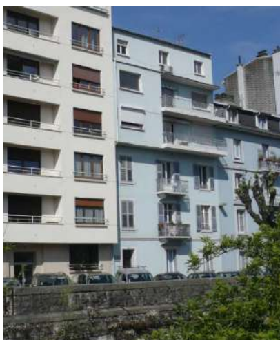
Quai Charles Ravet, immeuble de gauche
