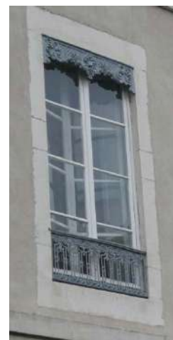
Double fenêtre à Grenoble correctement intégrée
