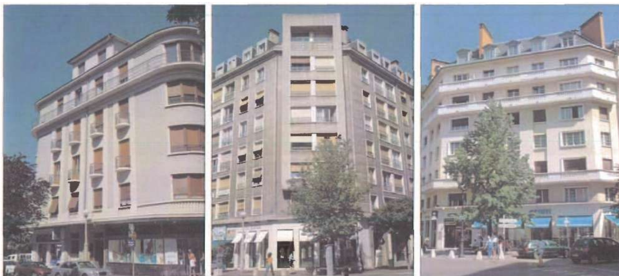
Les immeubles divers de la Reconstruction
