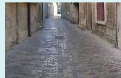
Pavés rejointoyés avec caniveau central
