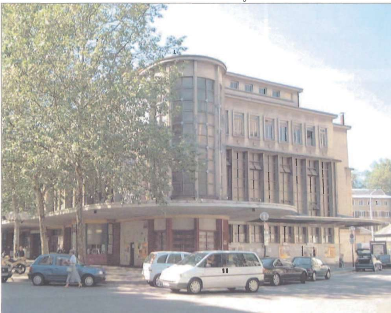
La halle des frères Bourdeix avant sa restructuration
