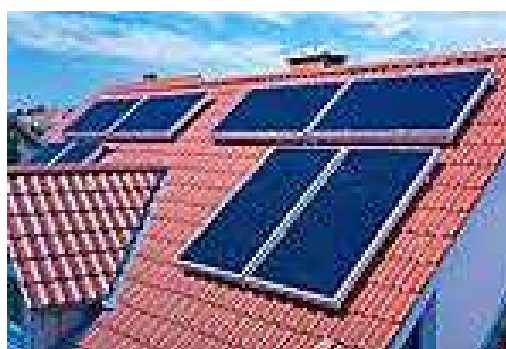
les panneaux posés en superposition, les cadres de teinte différente, le manque d'organisation.
