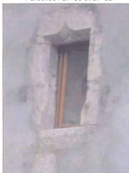
Fenêtre en «accolade» du 16 e siècle à la plaine de la Cassine
