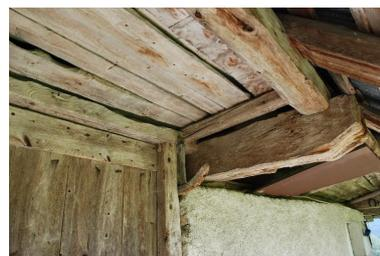
Détail des assemblages de charpente sous l'avant-toit.
