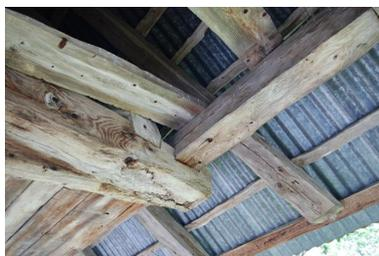
Détail des assemblages de la charpente dans le débord de toiture.
