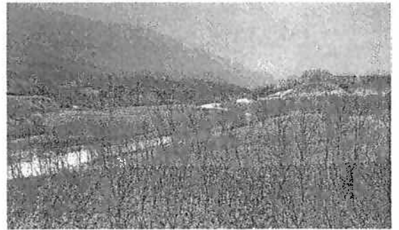
Réhabilitation agricole effectuée
