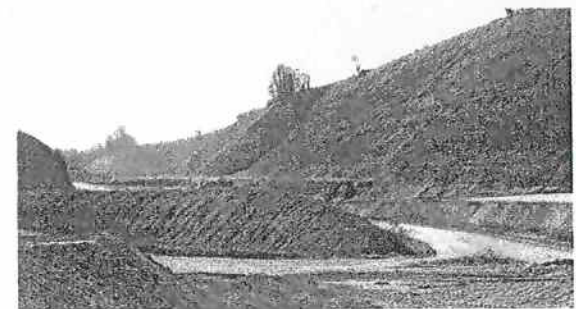
Partie sud à réhabiliter
