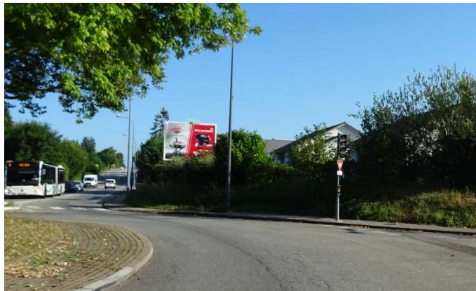
Dispositif au sein d'une zone d'habitat, rond-point Marius Berlioz à Chambéry // Even Conseil
