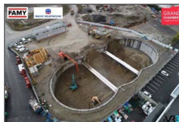
Phase 2 : Terrassement de l'ouvrage
