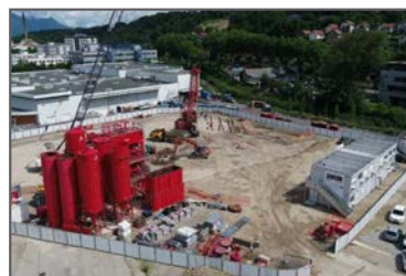
Phase 1 : Réalisation des parois moulées
