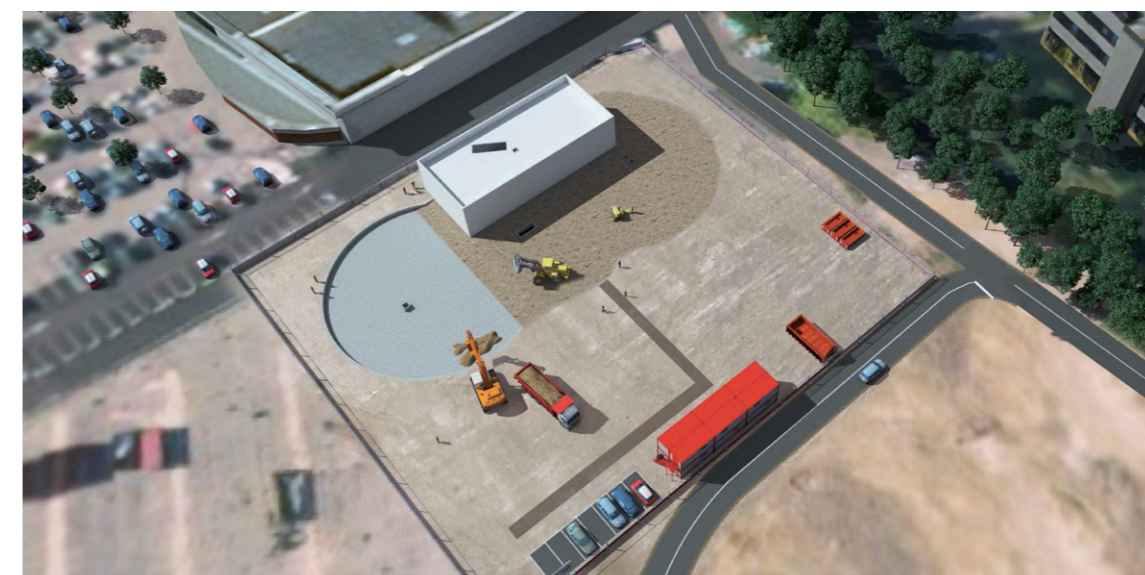
Terrassement - remblaiement sur dalle
