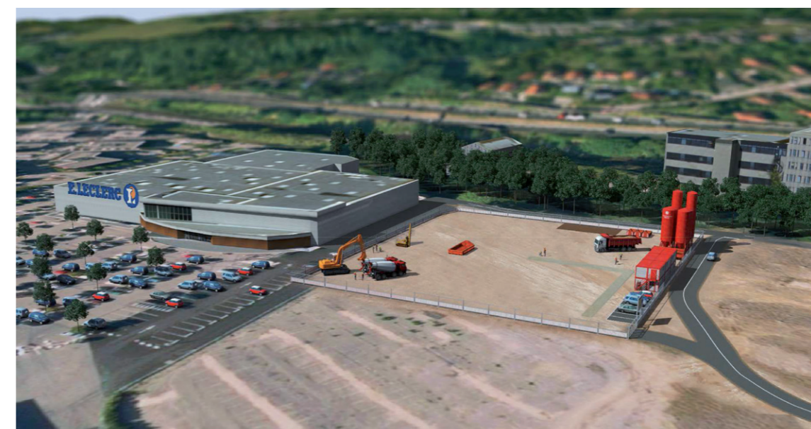
Installations de chantier, purges préliminaires, sondages complémentaires
