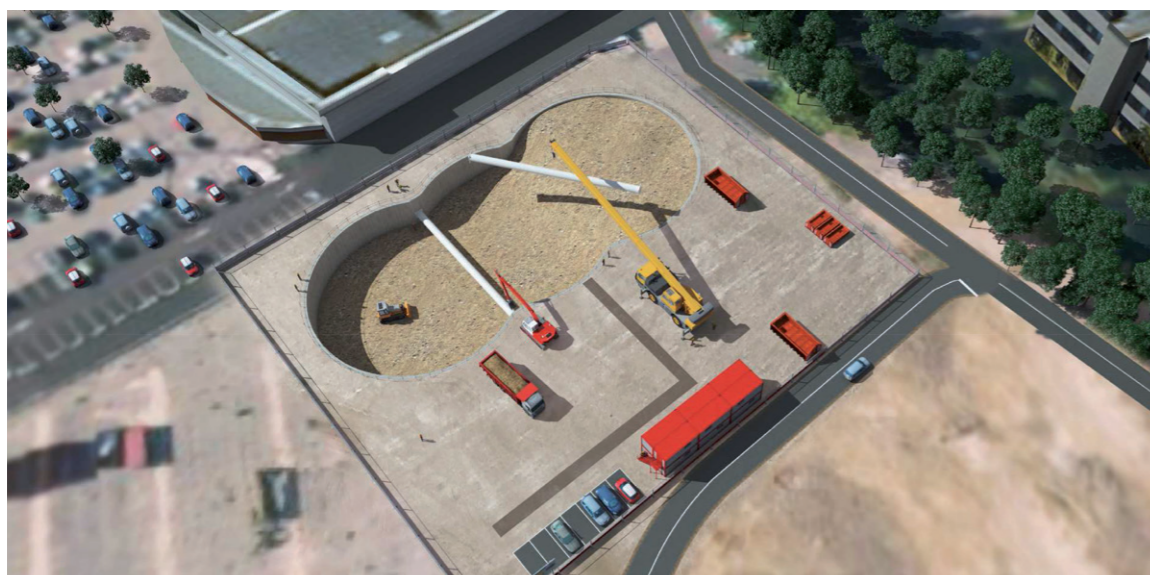
Terrassement et butons
