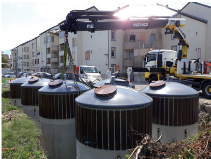
Installation des conteneurs semi-enterrés du Mas Barral à Chambéry
