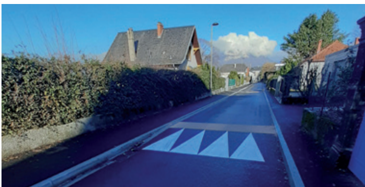
Route de la Cascade, Jacob-Bellecombette Montant des travaux : 221 000 € HT
