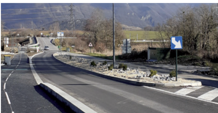
Avenue des Chevaliers Tireurs, Saint-Baldoph Montant des travaux : 804 000 € HT dont 696 000 € HT pour Grand Chambéry
