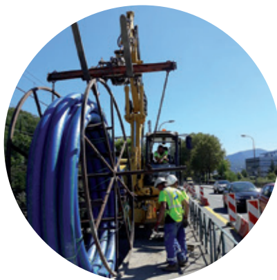
Réhabilitation des conduites d'eau potable par éclatement, avenue de La Boisse et avenue des Ducs, Chambéry
