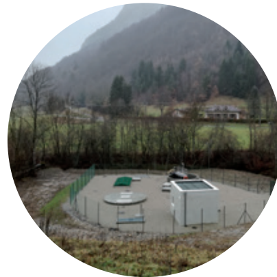
Construction du réservoir du Mollard 2, cuves de 400 m 3 , Bassens
