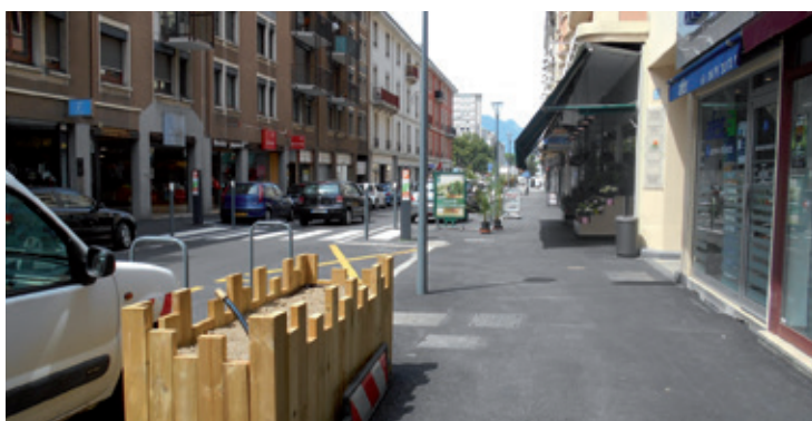
Rue Sommeiller, Chambéry Montant des travaux : 255 000 € HT
