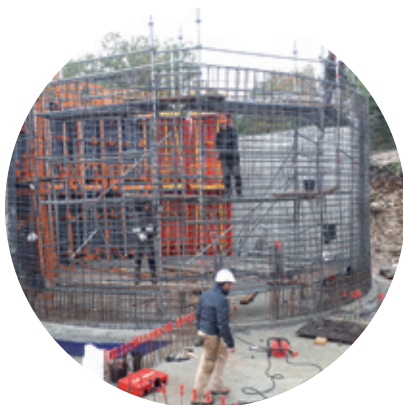
Création de la station d'épuration, La Thuile
