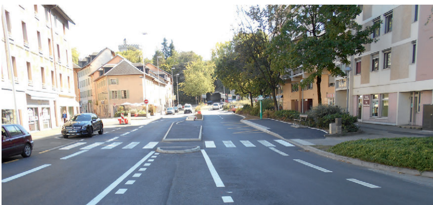
Avenue des Bernardines, Chambéry Montant des travaux : 125 000 € HT
