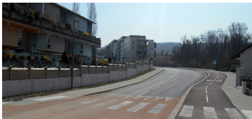
Rue de la Forêt, Cognin Montant des travaux : 392 000 € HT
