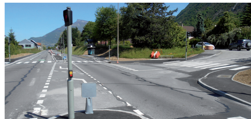
Carrefour Gabelle, Saint-Jeoire-Prieuré Montant des études et travaux : 165 K€ HT
