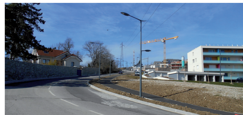
Chemin des Monts Dessus, Bassens et Chambéry Montant des études et travaux : 370 K€ HT
