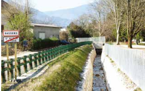
Aménagement de protection contre les crues du Nant Petchi, rue des contours à Bassens.
