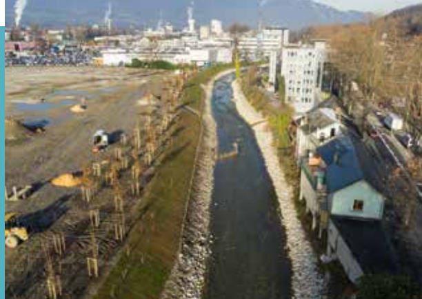
Aménagement de la Leysse le long de l'avenue de la Boisse
