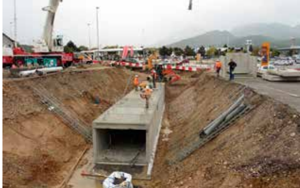
Travaux du Nant Pecthi, traversée sous le parking Carrefour Bassens
