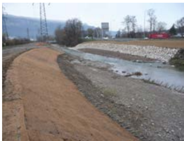
La Leysse après travaux de recalibrage et de renaturation
