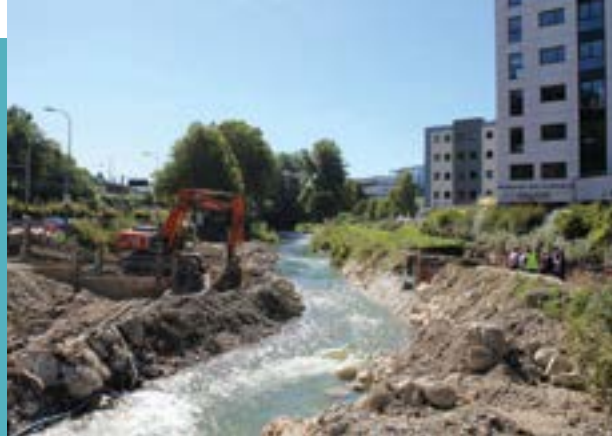
Installation de collecteurs unitaires sous la Leysse
