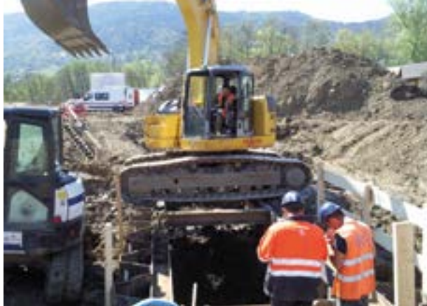
Installation d'une conduite d'adduction d'eau entre Challes-les-Eaux et Saint-Baldoph.
