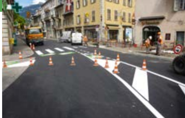
Traversée rue Jean-Pierre Veyrat
