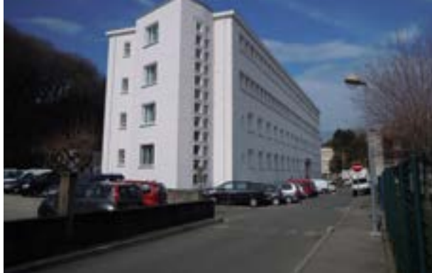
Maison des Syndicats après travaux
