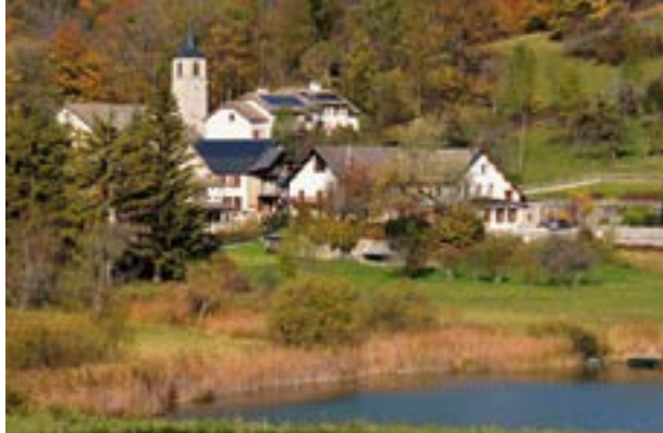
Centrale villageoise photovoltaïque à La Thuile.
