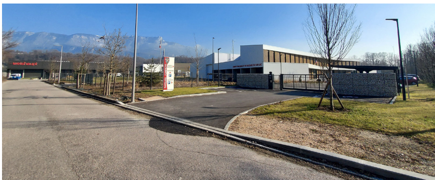
Landiers ouest, nouveau bâtiment SDIS
