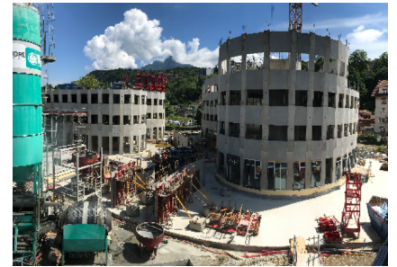
Chantier du Linklab au 23 juin 2021
