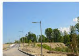
Route d'accès au site déjà équipée par le système d'éclairage public.
