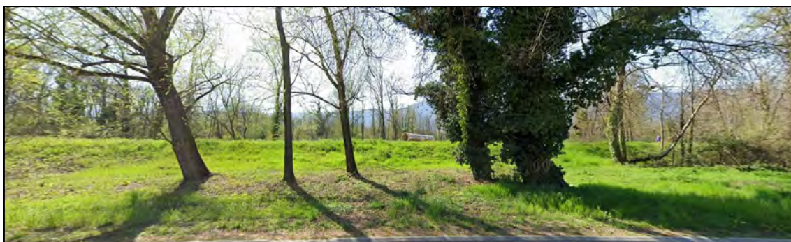
Figure 89: Prise de vue de la digue en rive droite (Source : Google maps)
