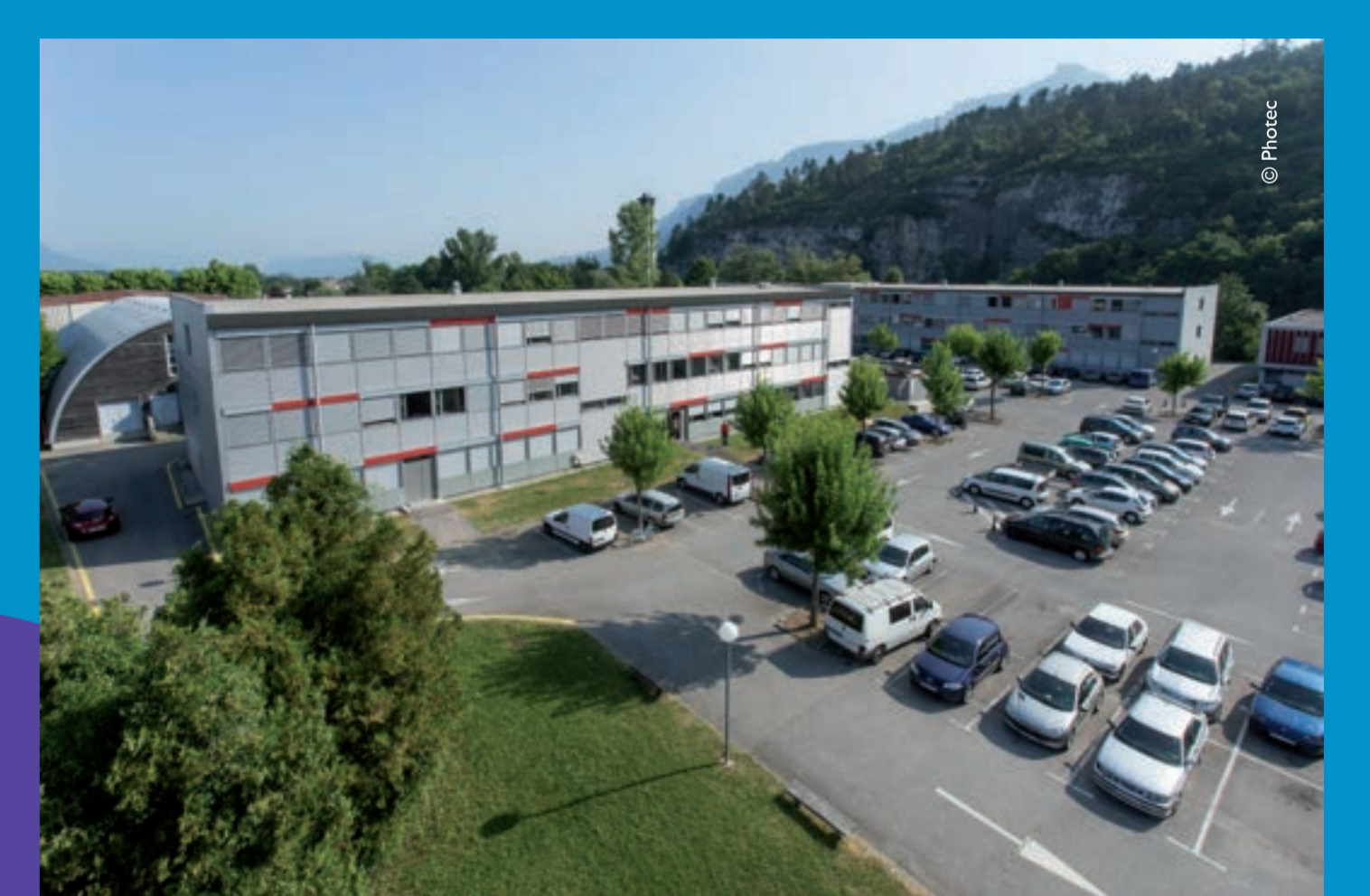
2013 Les bâtiments A, B et C après réhabilitation.
