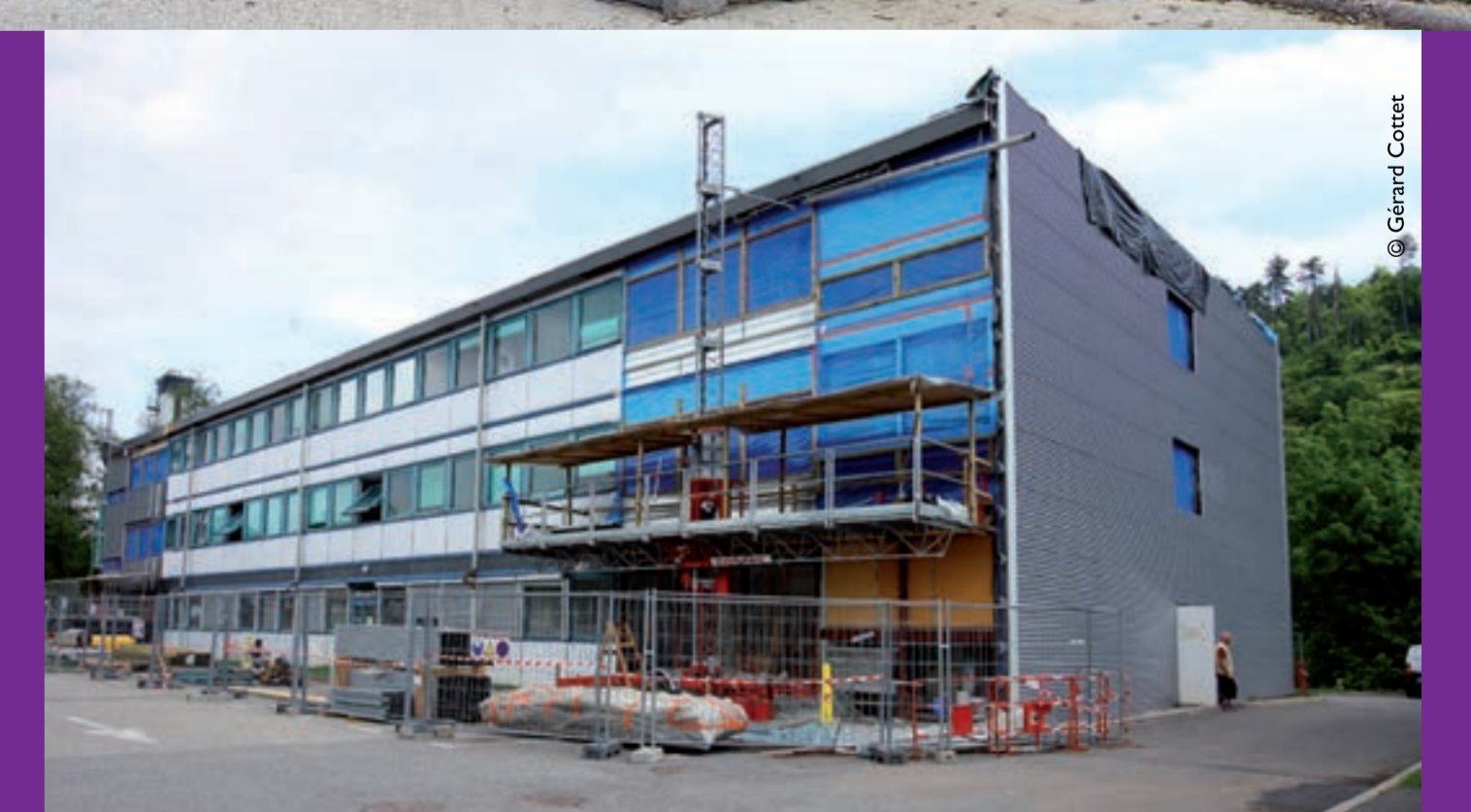
2010 Travaux de rénovation du bâtiment B.
