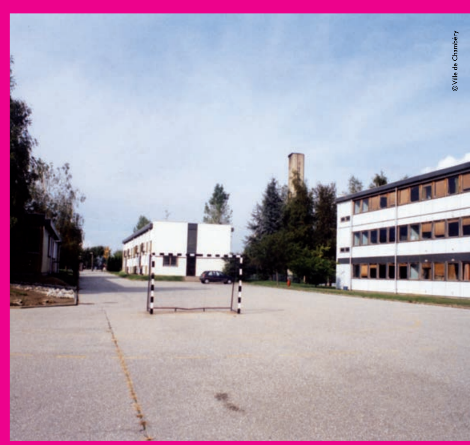
1987 A droite, les salles de classe du bâtiment B.
