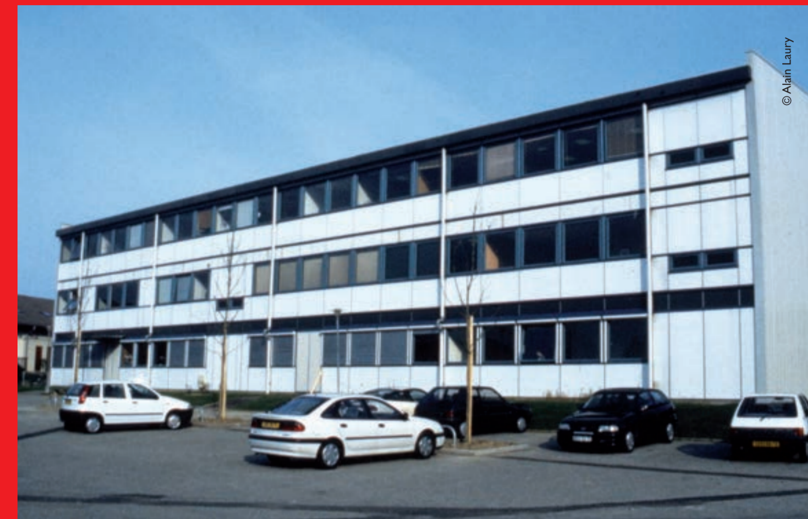
1997 Bâtiment A avant réhabilitation.
