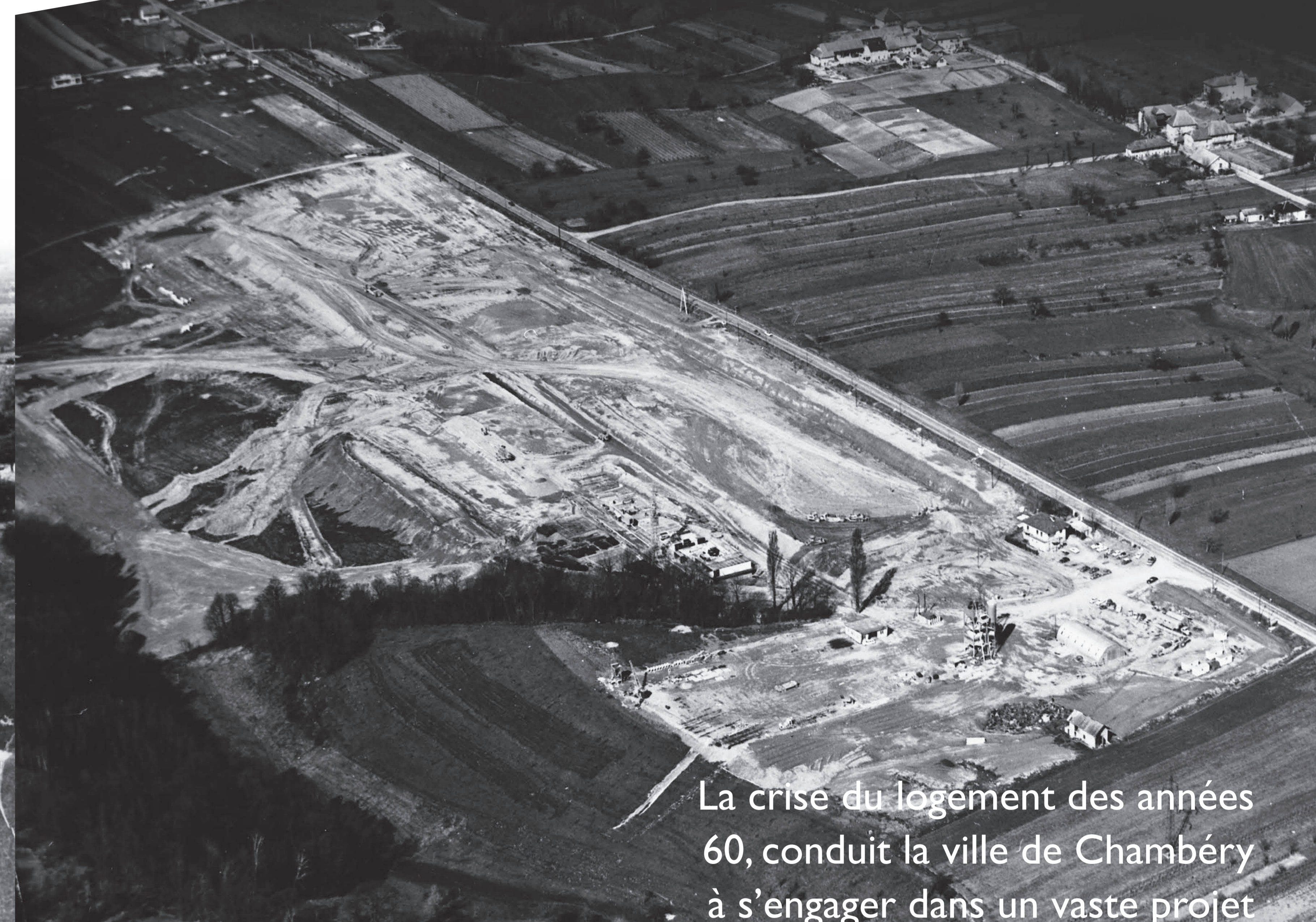
1966 - Chambéry-le-Haut : plateau de la Croix Rouge, début du terrassement de la ZUP.
