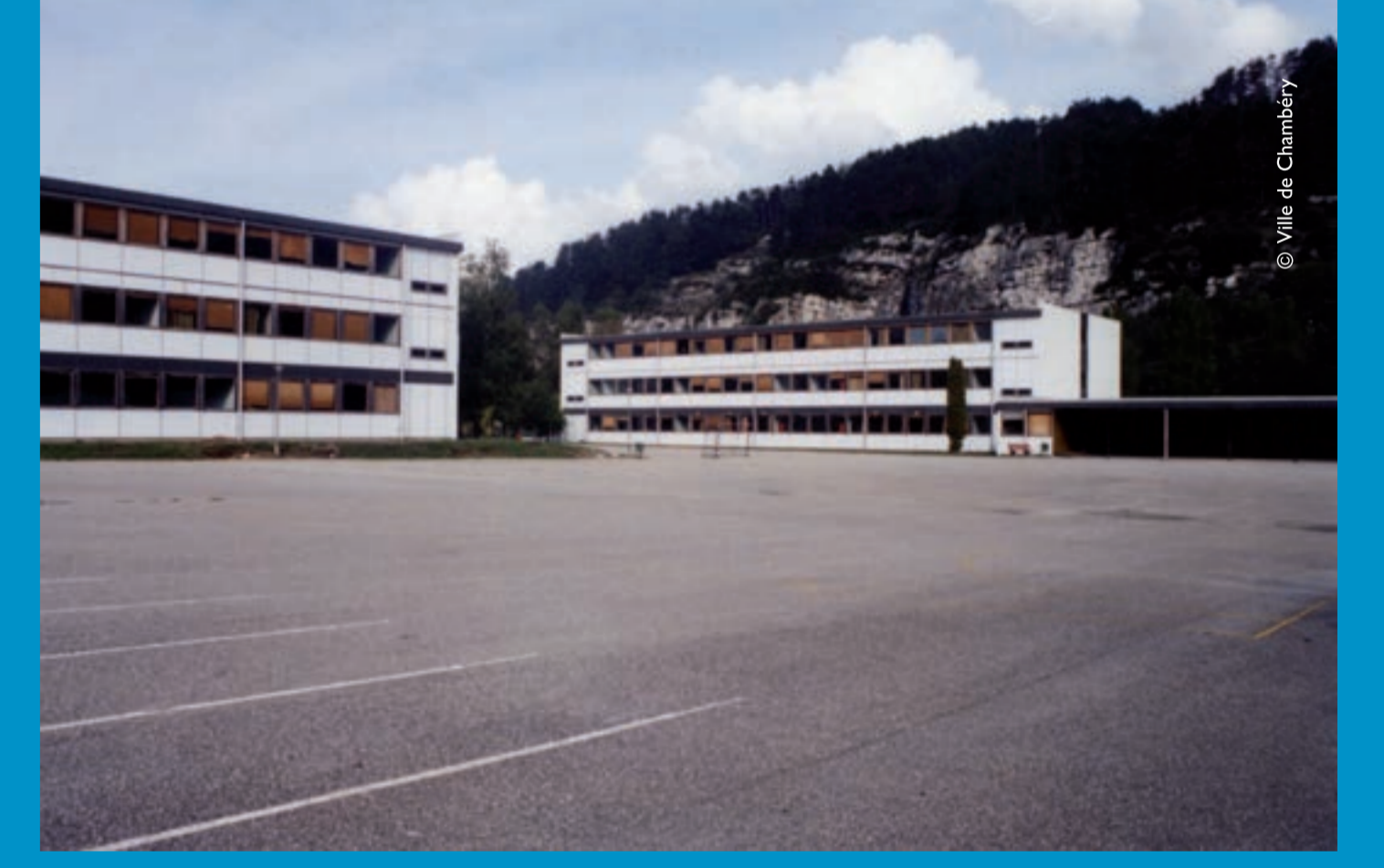
1993 Les bâtiments A, B et C avant réhabilitation.
