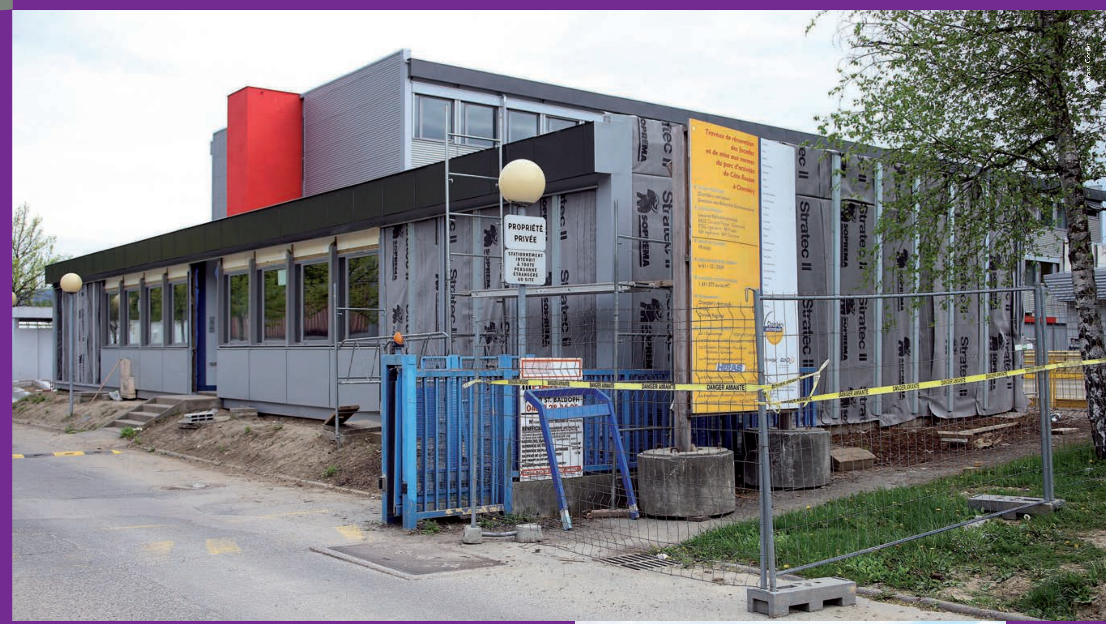
2011 Rénovation du bâtiment F.
