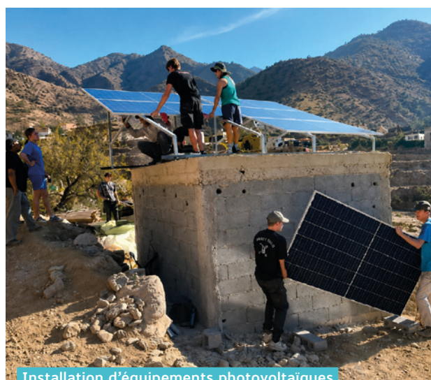
Installation d'équipements photovoltaïques
