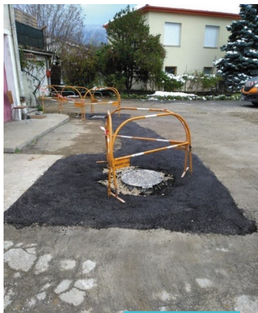
Création d'un regard
