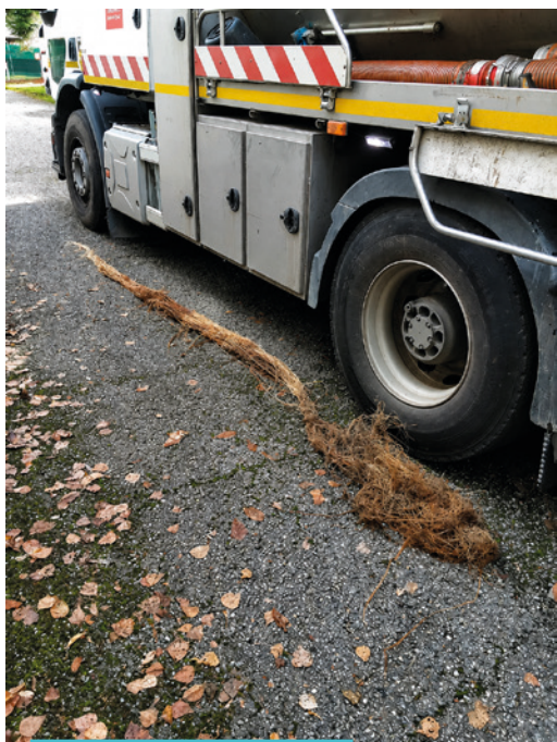
Racine enlevée des réseaux
