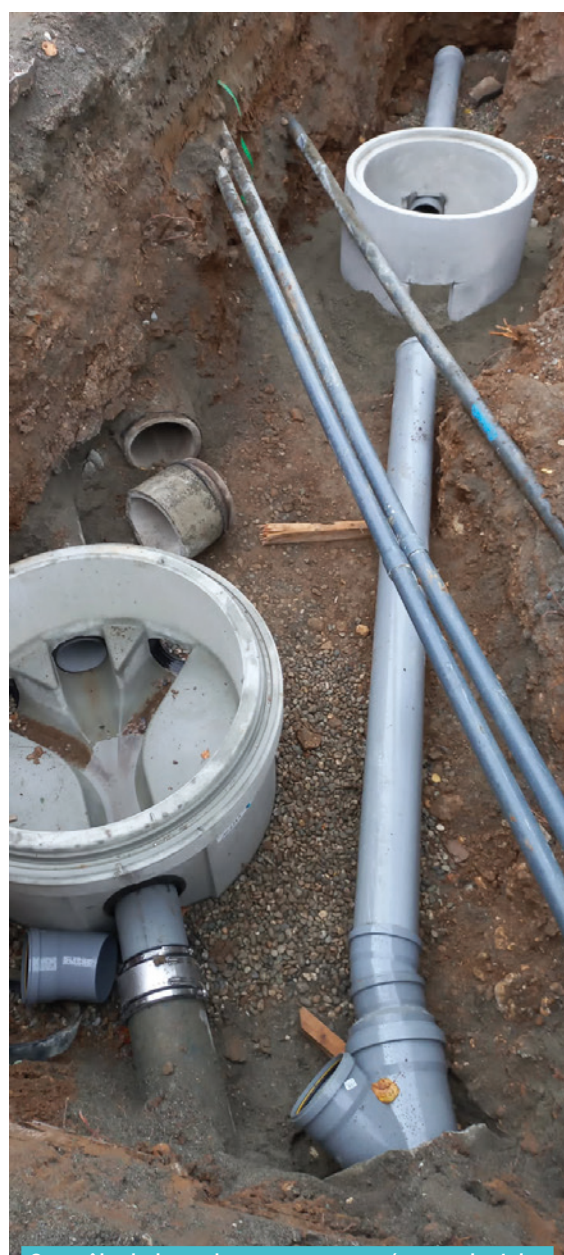
Contrôle de branchements eaux usées et pluviales
