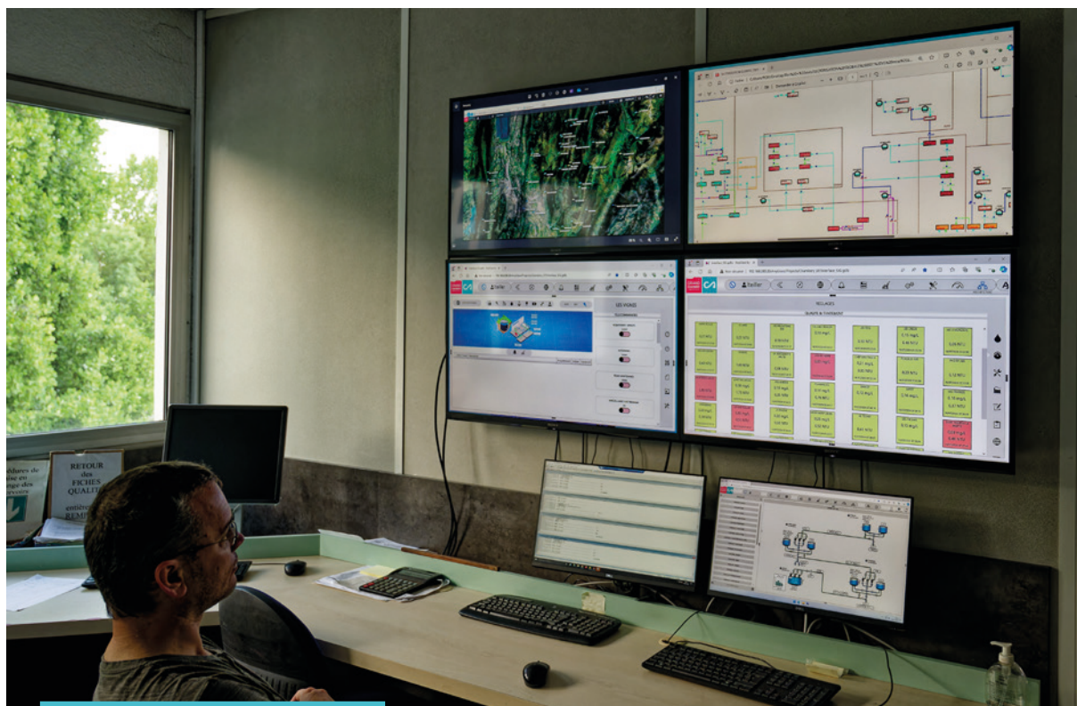
Supervision du niveau d'eau potable
