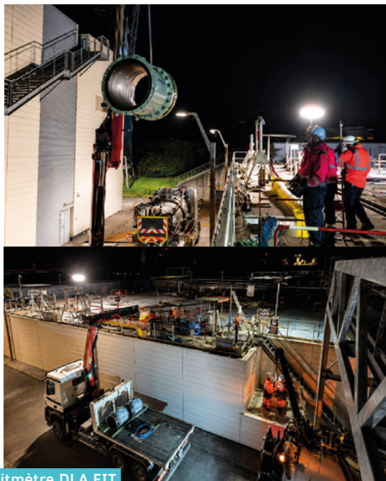
Remplacement du débitmètre DLA FIT
