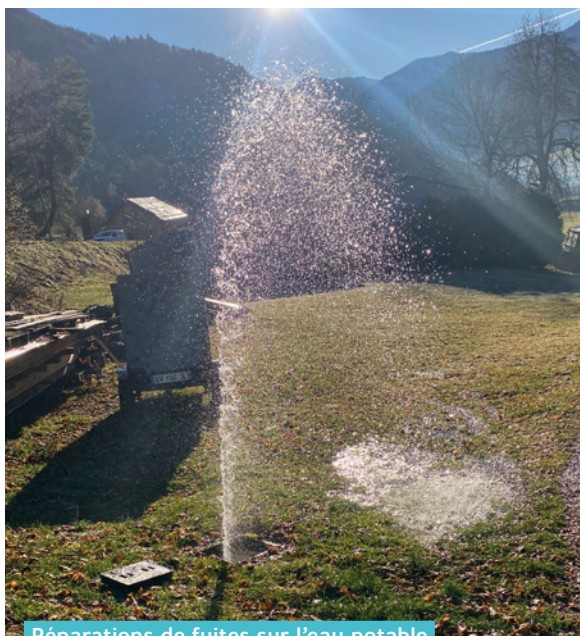
Réparations de fuites sur l'eau potable
