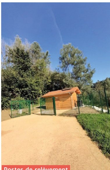
Postes de relèvement
