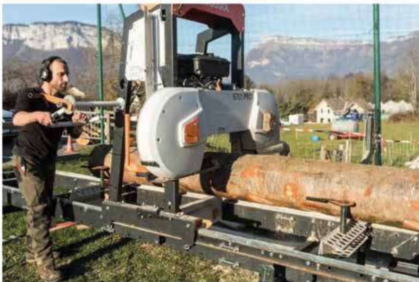
Démonstration de la scie mobile pour la construction de la cantine en bois très local : c'est le projet qui s'est adapté à la ressource forestière et non l'inverse
