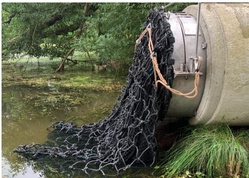
Filet à l'exutoire de réseau (source Pollustock)
