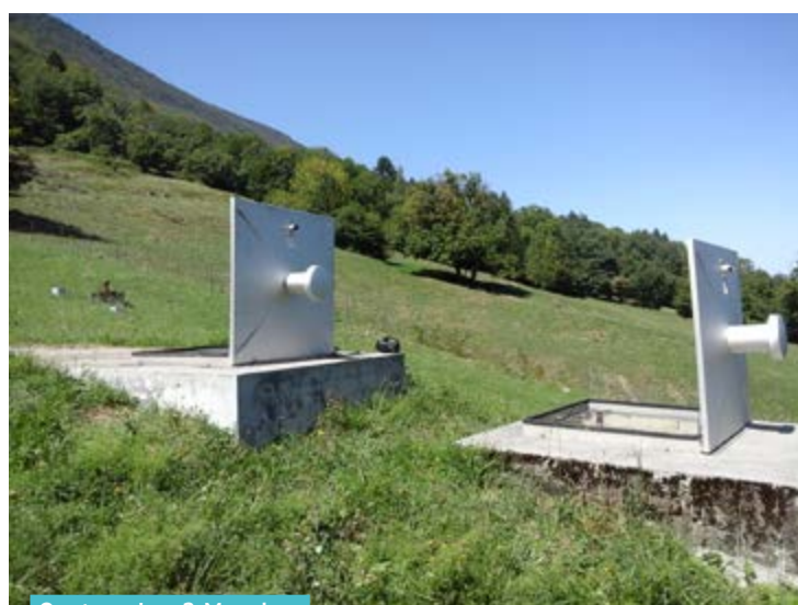
Captage Les 3 Murgiers
