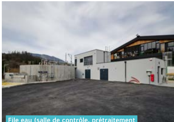
File eau (salle de contrôle, prétraitement et bassin d'aération)
