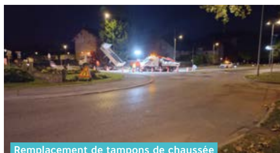
Remplacement de tampons de chaussée Phase travaux de nuit
