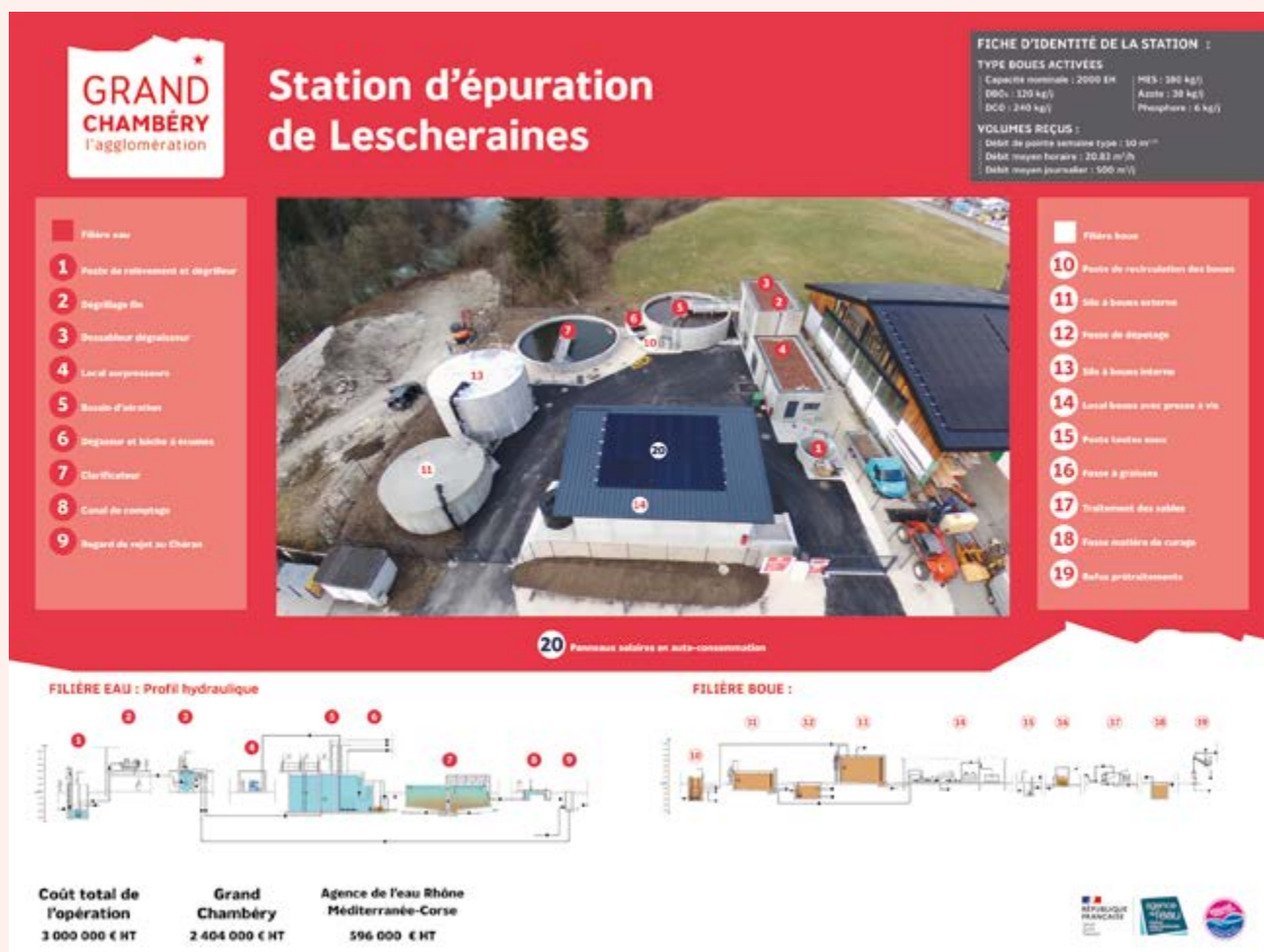
Panneau pédagogique de la station d'épuration de Lescheraines
