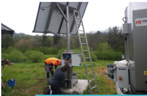
Mise en place du dégrilleur solaire sur la station de la Motte en Bauges
