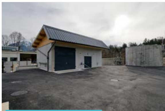
Local à boues avec presse à vis
