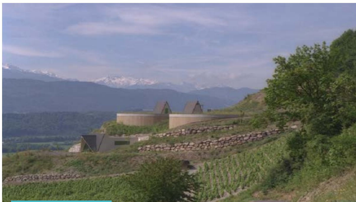
Réservoir Saint Jean de la Porte
