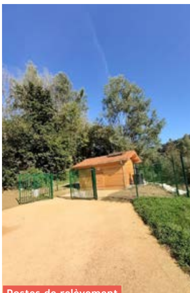
Postes de relèvement
