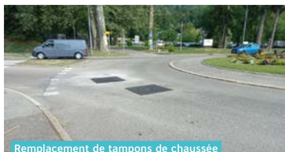
Remplacement de tampons de chaussée Après travaux
