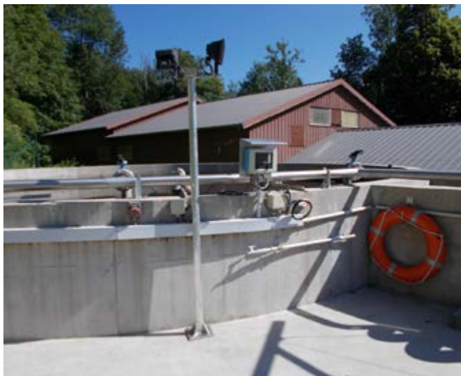
Station d'Épuration d'Aillon-le-Jeune
