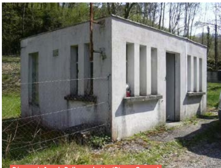
Réservoir Jacob Bellecombette (Pierre Grosse)
