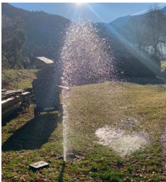
Réparations de fuites sur l'eau potable
