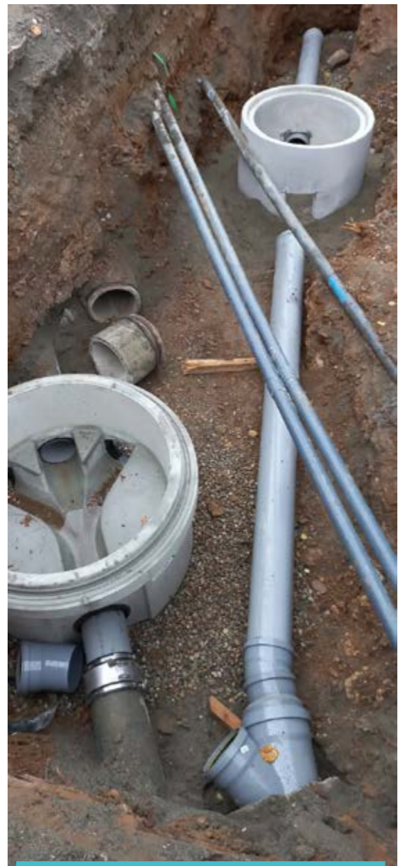
Contrôle de branchements eaux usées et pluviales
