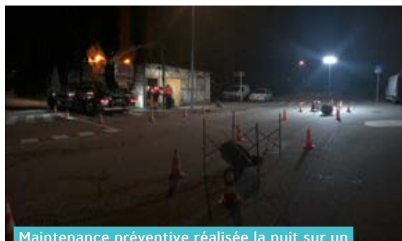
Maintenance préventive réalisée la nuit sur un poste de relèvement des eaux usées
