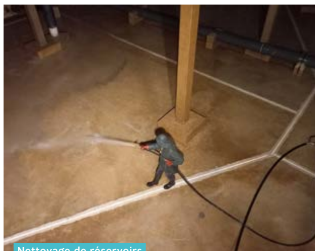
Nettoyage de réservoirs
