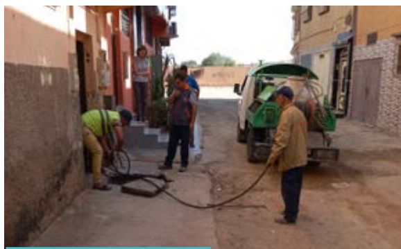
Taroudant entretien réseau
