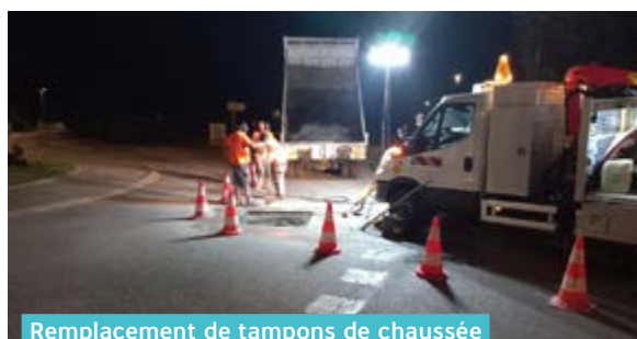
Remplacement de tampons de chaussée Phase travaux de nuit
