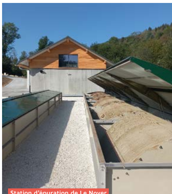
Station d'épuration de Le Noyer
