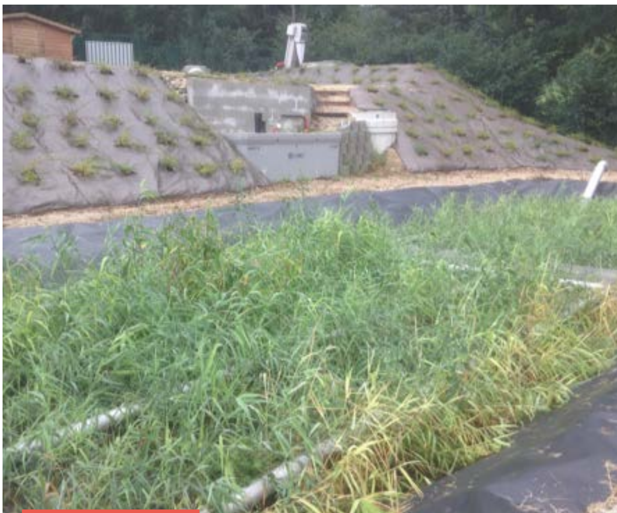
Step à filtres plantés de roseaux
