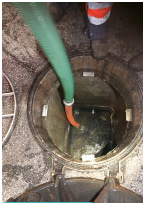
Curage d'un regard d'eaux usées
