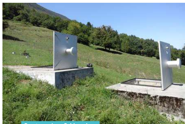
Captage Les 3 Murgiers
