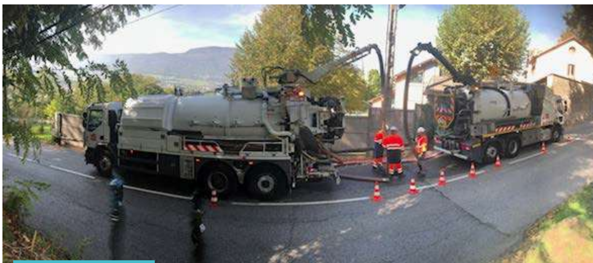
Réparations casse réseaux
