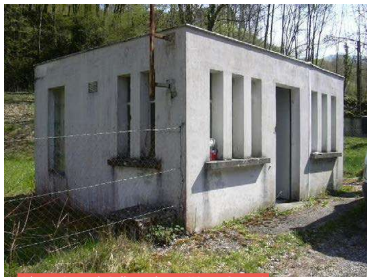
Réservoir Jacob Bellecombette (Pierre Grosse)
