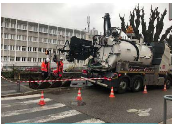
Maintenance préventive siphon pont des Carmes
