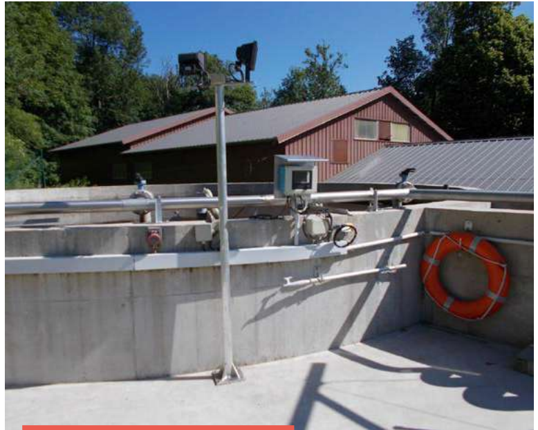
Station d'Épuration d'Aillon-le-Jeune
