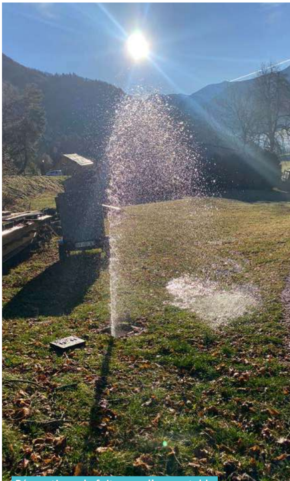
Réparations de fuites sur l'eau potable
