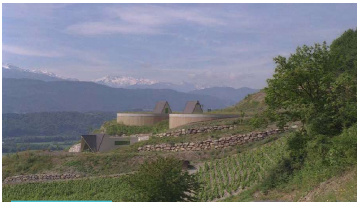
Réservoir Saint Jean de la Porte
