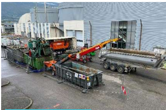
Maintenance des digesteurs
