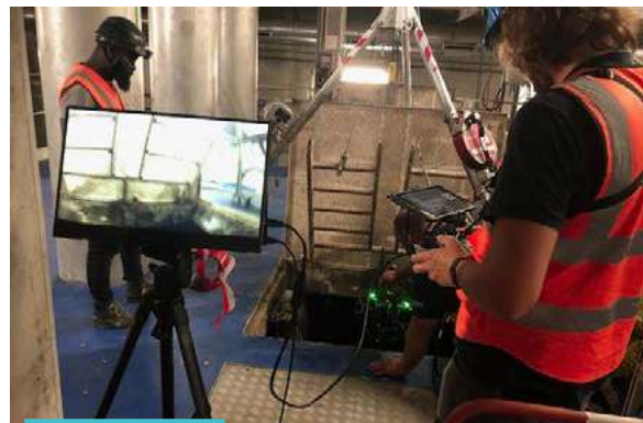
Photo par drone
