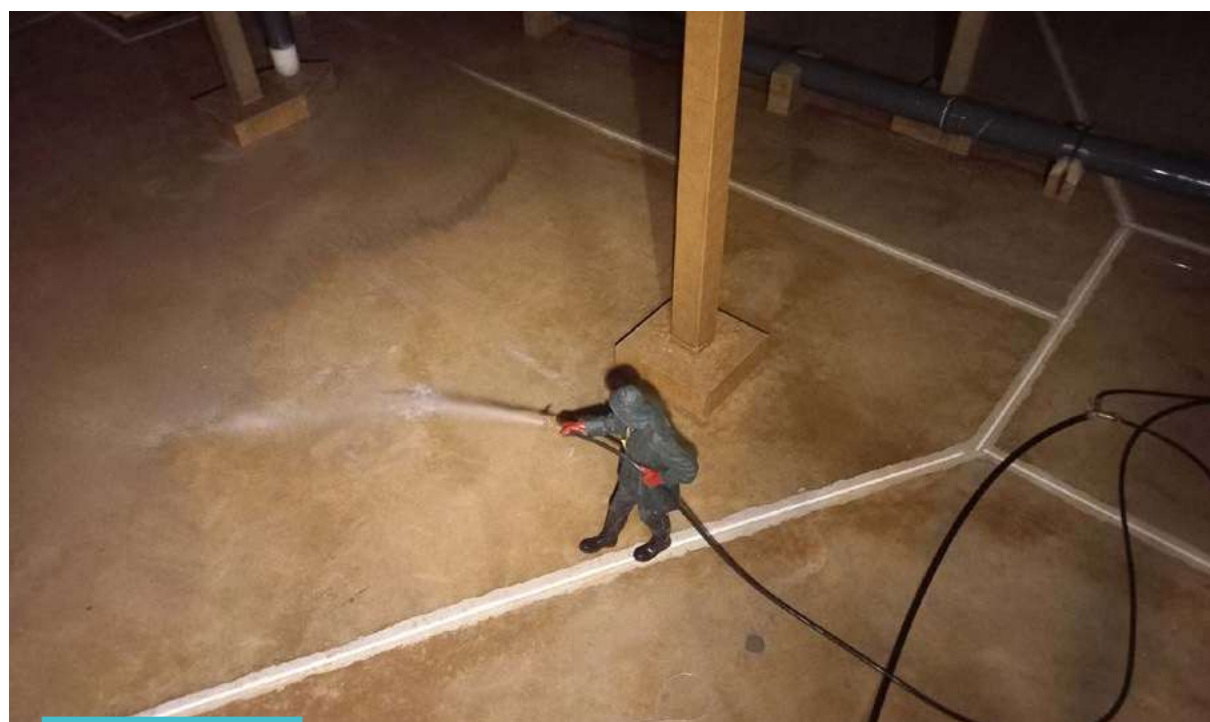
Nettoyage de réservoirs
