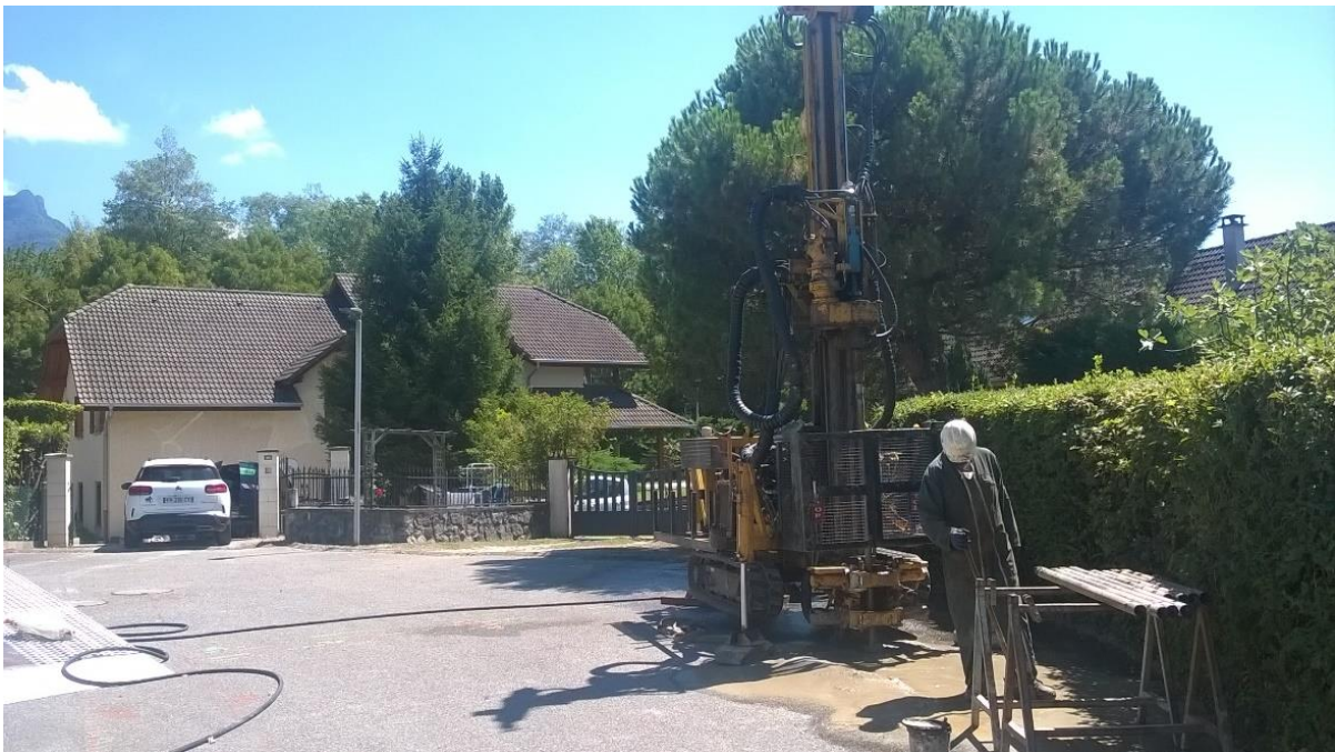
Figure 5 : Localisation du forage SD2a, Allée du Clos Noiray à Voglans
