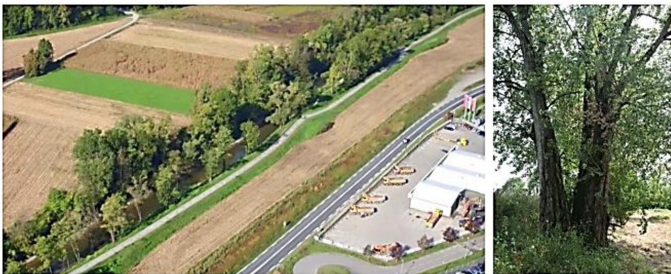
Figure 8 : Vue aérienne permettant de distinguer, sur la digue rive droite au premier plan, le talus aval sans végétation arborée du talus amont. A droite : peuplier noir sur le talus amont à l'amont du pont du Tremblay.
