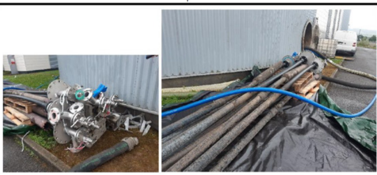
figure 4 : cannes de brassage du digesteur 1 déposée et stockées
