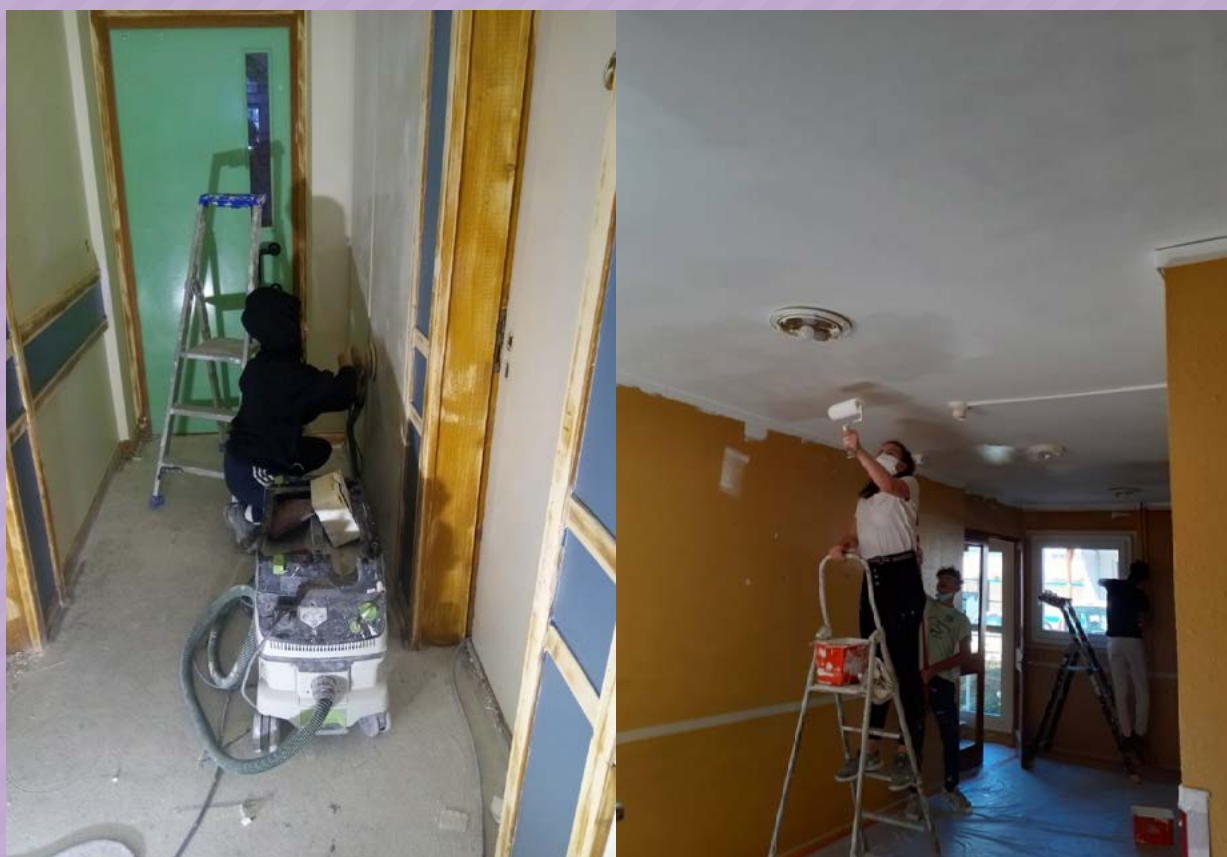
Travaux de peinture réalisés par les jeunes des chantiers éducatifs © DR
