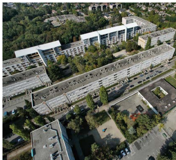
Bâtiment du Bois joli © Grand Chambéry
