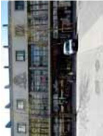
Les Halles de Chambéry (1933 - 1945) patrimoine du XX e ème siècle non labellisé
