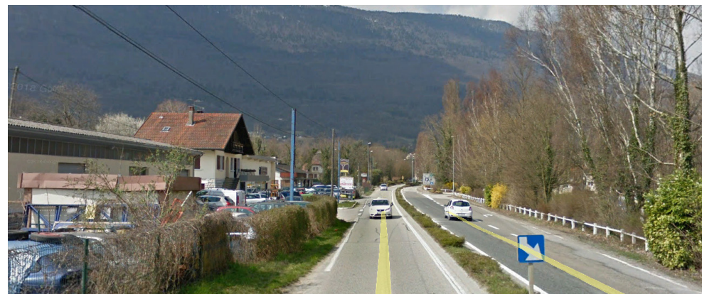
Vue de la RD1504 au niveau de l'arrivée sur le Bourget-du-Lac, avec le rideau d'arbres côté Technolac et les constructions d'activités économiques qui se sont développés côté Ouest.
