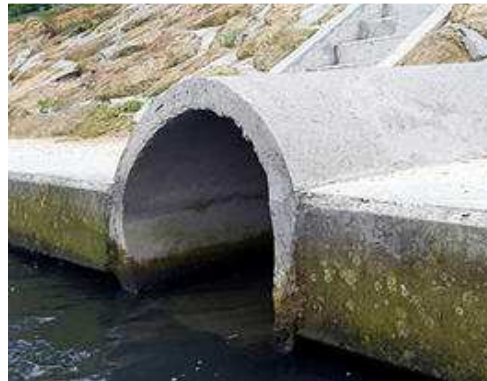
Figure 2 : Exemple de rejet d'eaux pluviales dans un cours d'eau
