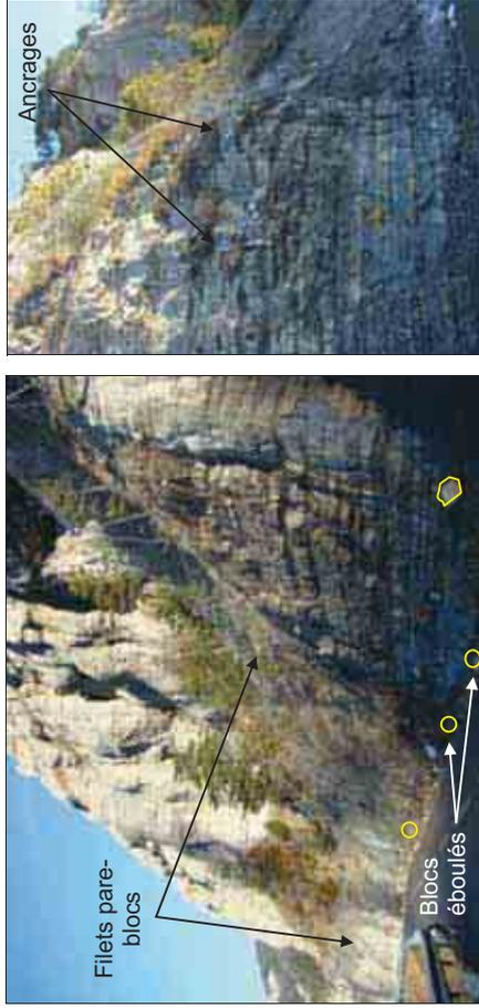
Figure 22 : Affleurements confortés le long de la RD 912 [Source : IMS<sub>RN</sub>]
