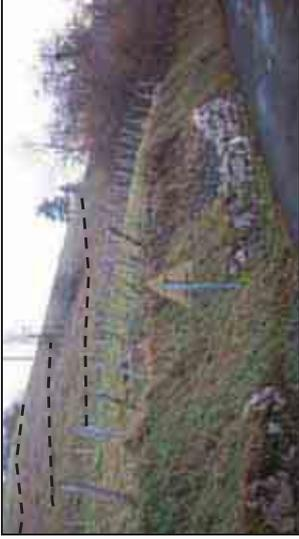
**Figure 34 :** Poteau incliné, rides de glissement et mur de confortement [Source : IMS<sub>ovl</sub>]
