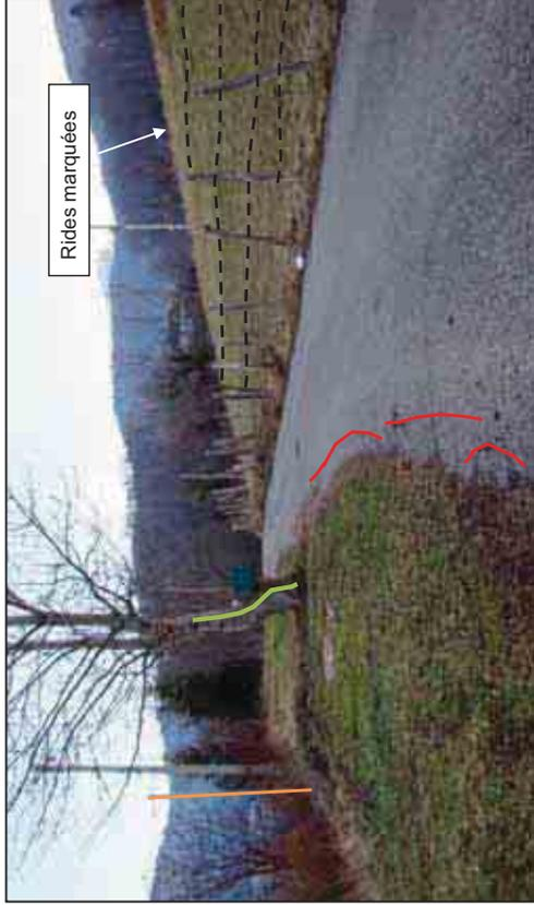
**Figure 35 :** Nombreux indices de déformation en amont du versant [Source : IMS<sub>ovl</sub>]
