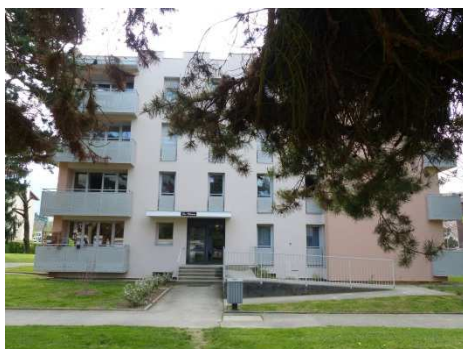
Création de rampe d'accès
