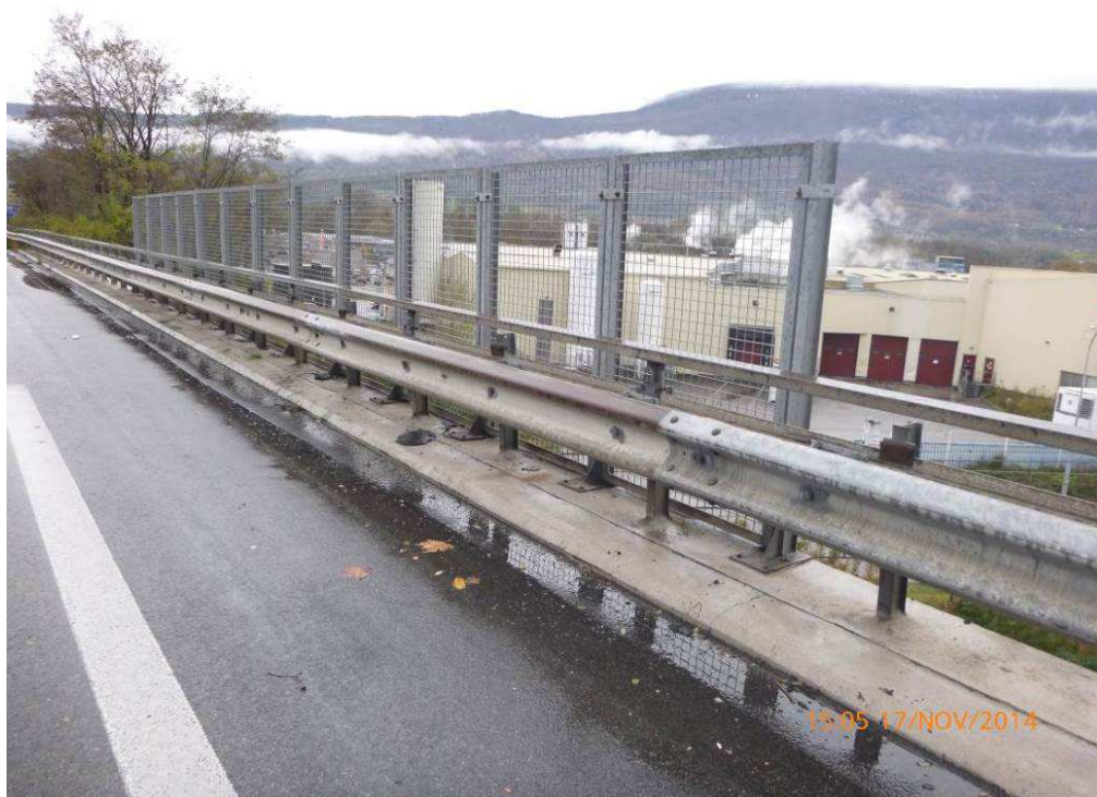
Photo n°5 : Voie nord côté Genève, vue de l'accotement
