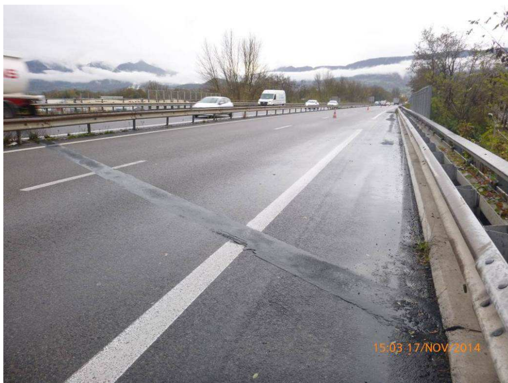
Photo n°2 : Voie nord côté Genève, vue sur la chaussée
