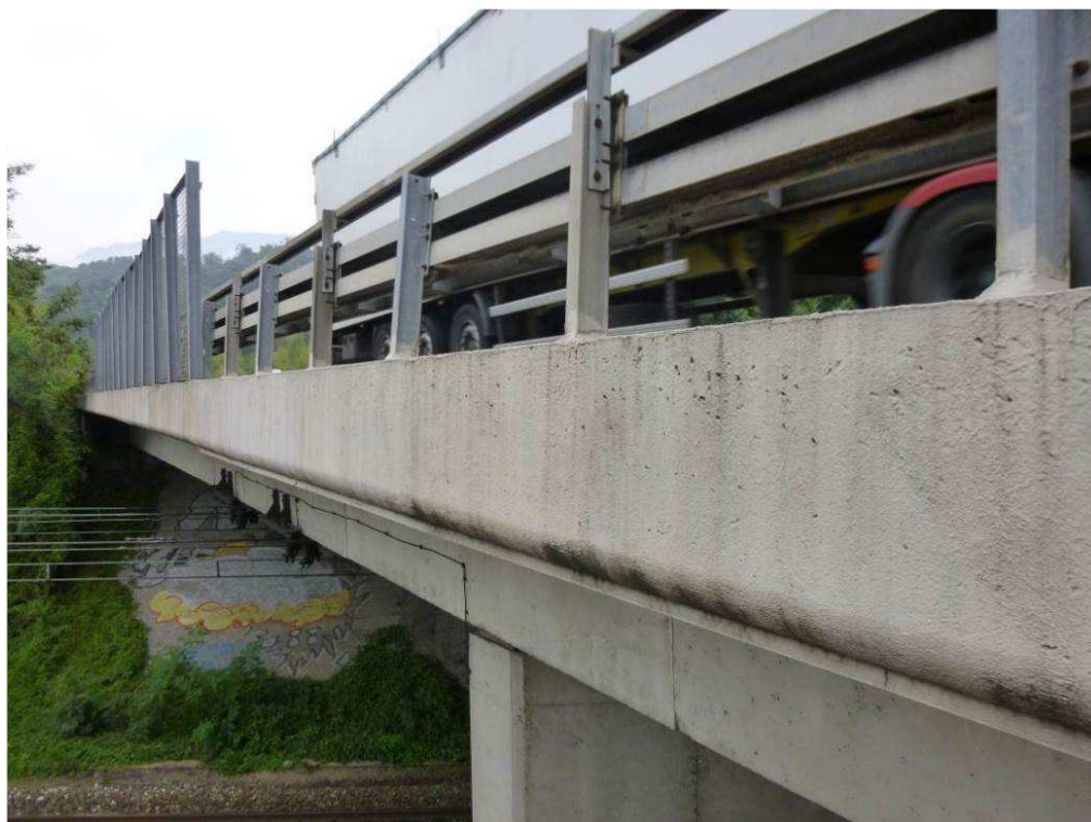
Photo n°14 : Voie nord côté Lyon, vue sur la corniche
