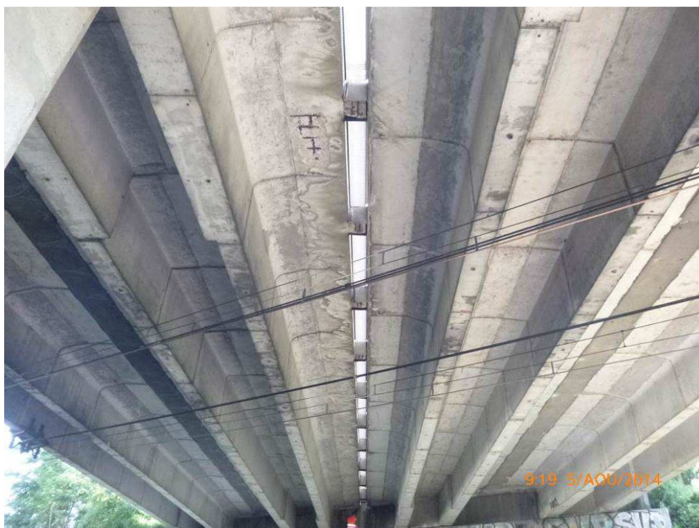
Photo n°17 : Côté SNCF, vue de l'intrados
