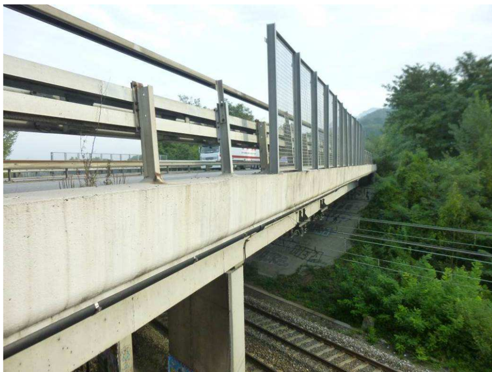
Photo n°13 : Voie sud côté Lyon, vue sur la corniche
