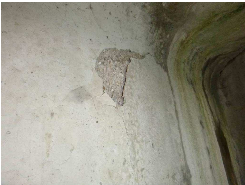
Photo n°21 : Côté SNCF intrados, éclat en formation en about de poutre
