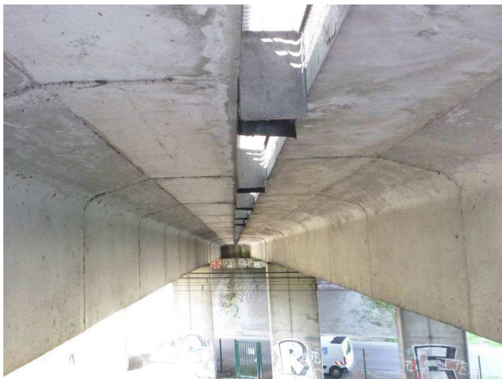
Photo n°18 : Côté SNCF intrados, vue de l'axe de l'ouvrage
