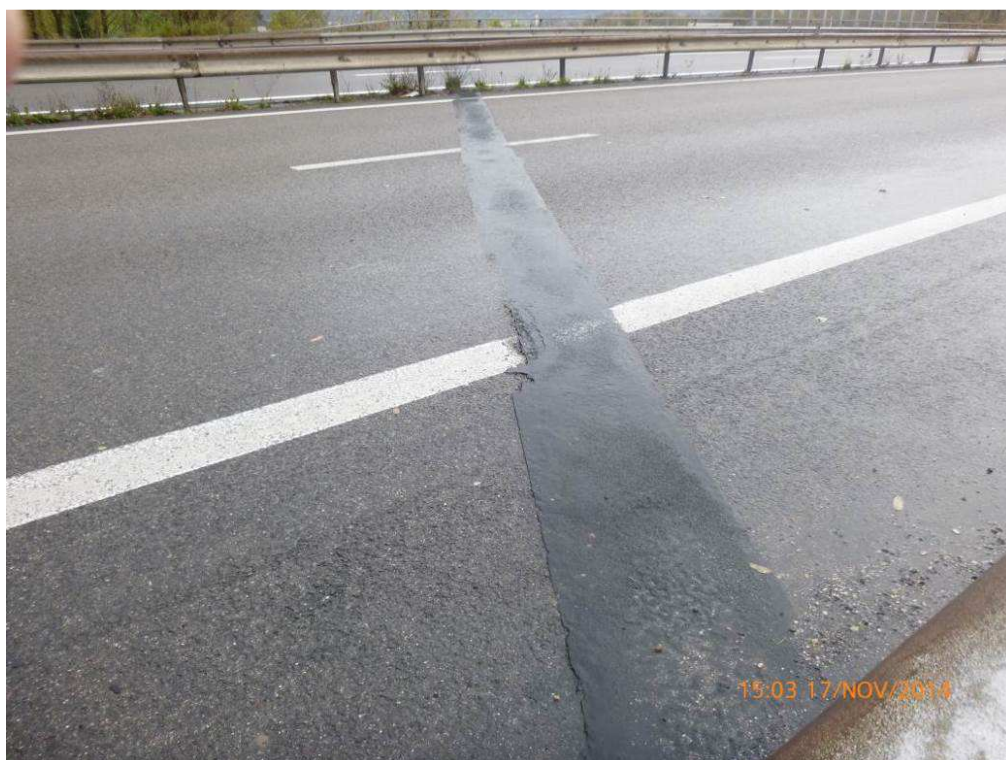
Photo n°9 : Voie nord côté Genève, reprise sur joint souple avec une zone décollée
