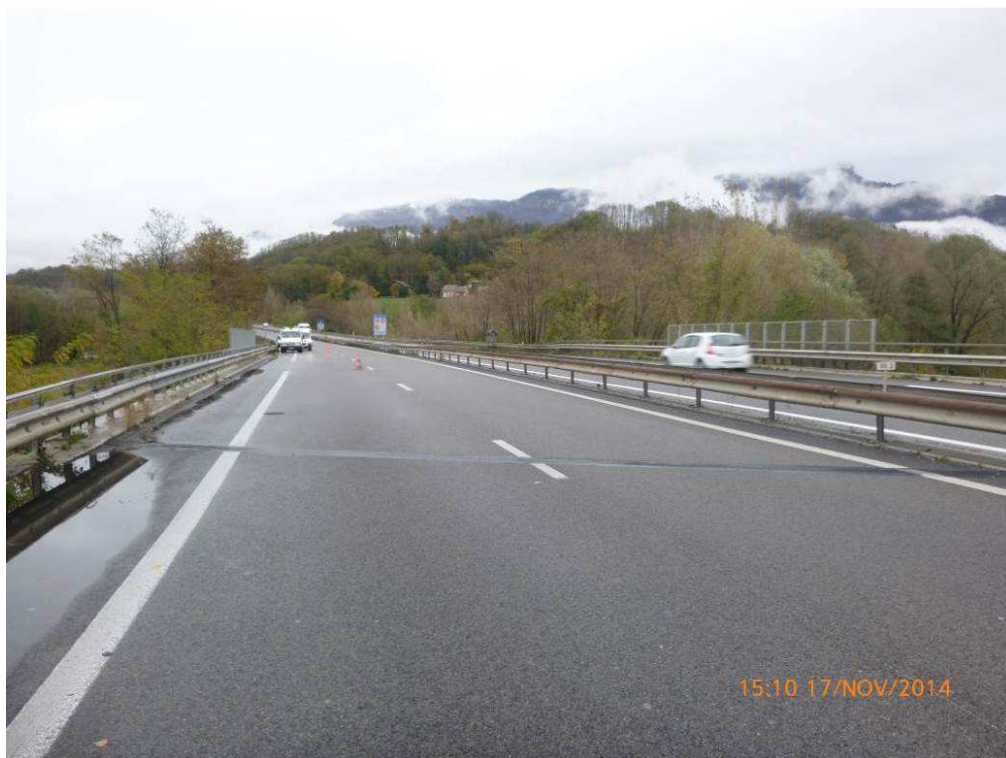
Photo n°1 : Voie nord côté Lyon, vue sur la chaussée
