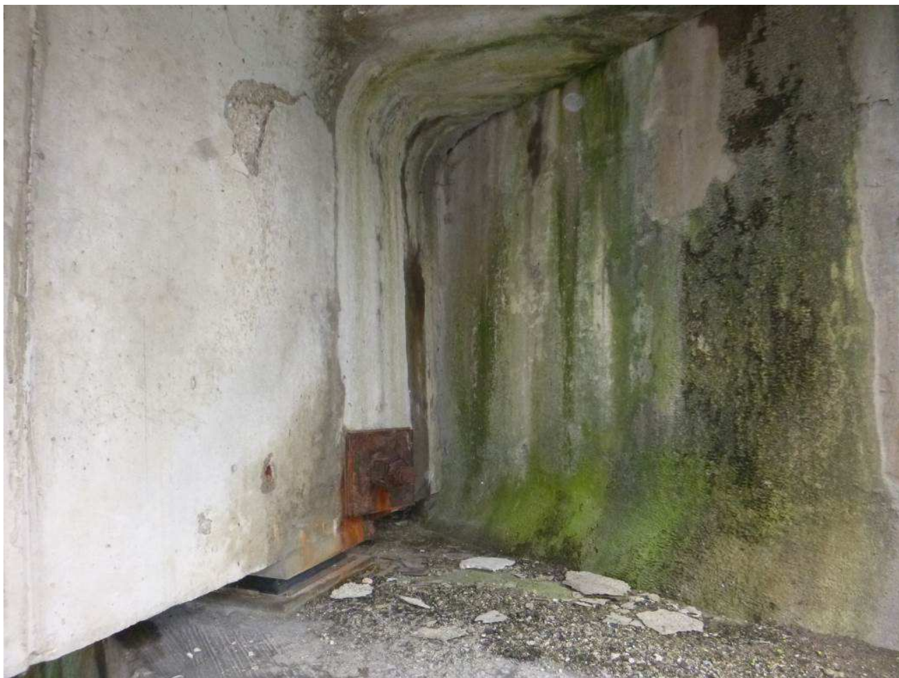
Photo n°30 : Culée C2, coulures humides sur le mur garde grève
