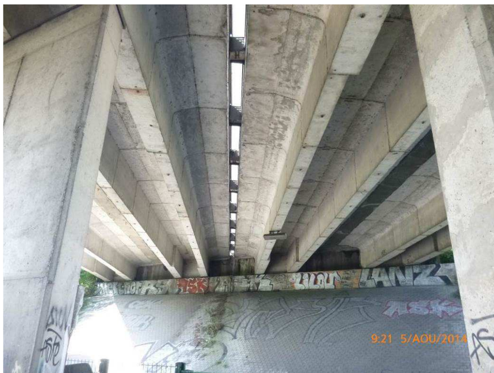
Photo n°16 : Côté RD, vue de l'intrados
