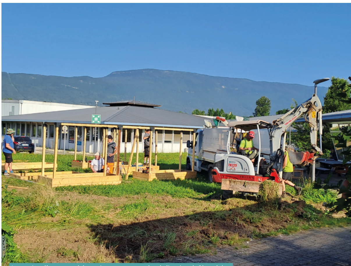
Le projet d'espace pédagogique en cours de réalisation à Chambéry
