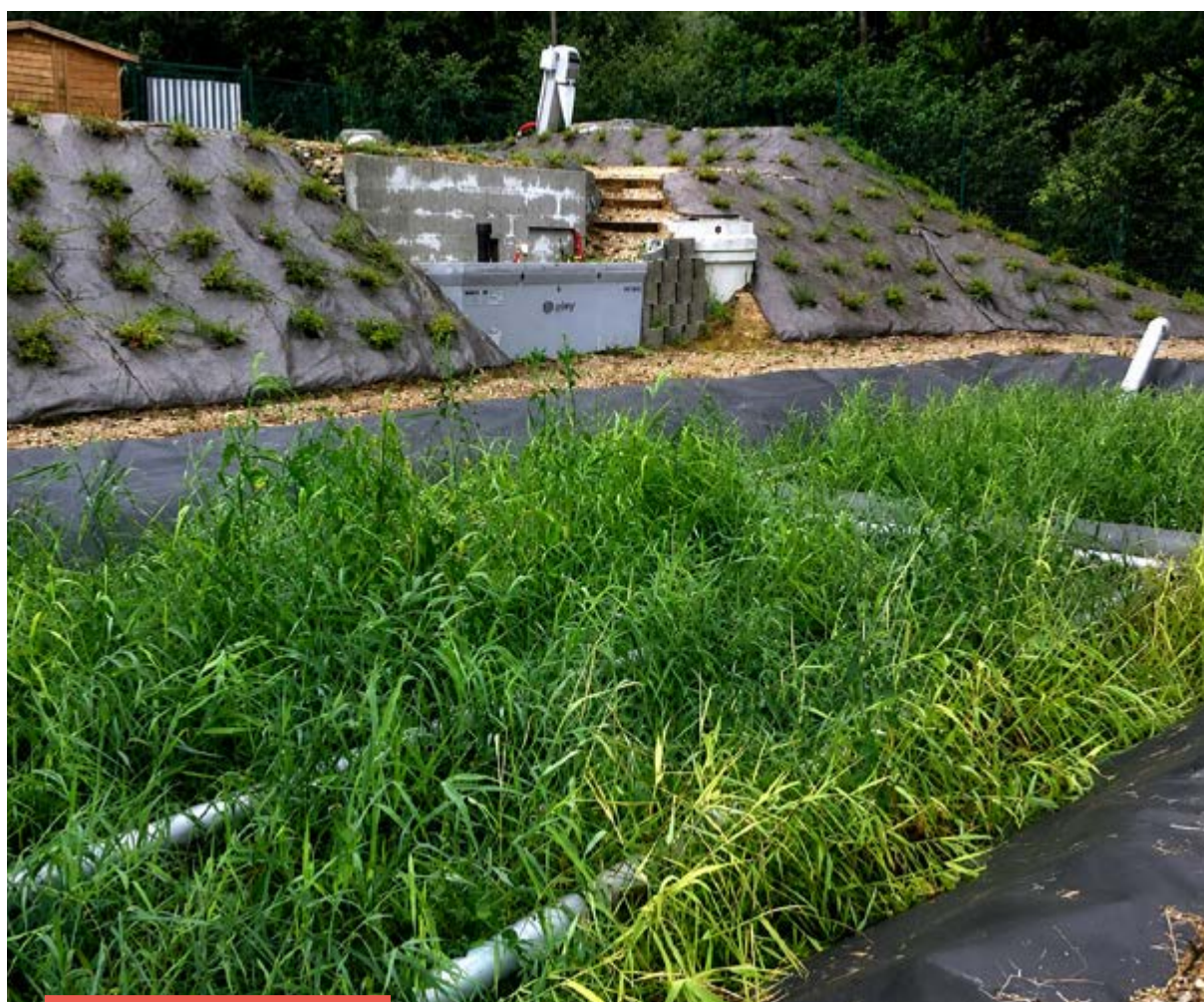
Step à filtres plantés de roseaux
