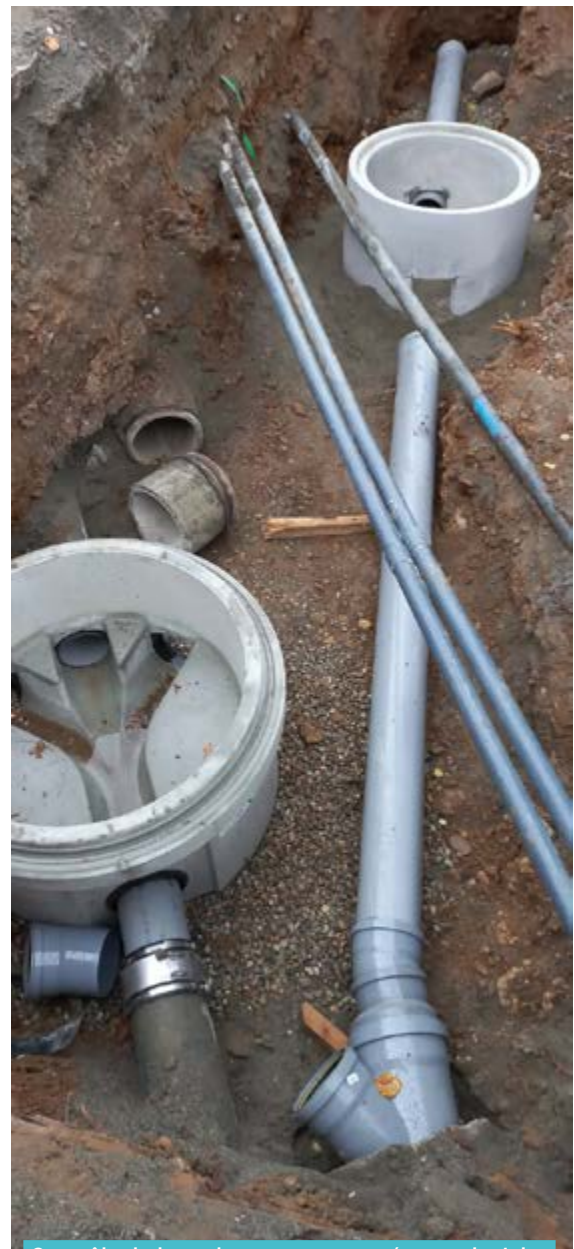
Contrôle de branchements eaux usées et pluviales
