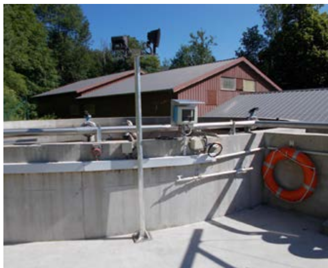
Station d'Épuration d'Aillon-le-Jeune
