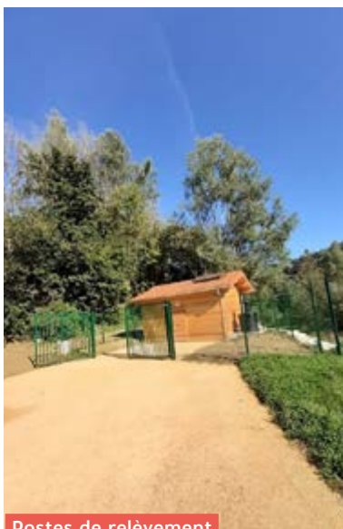
Postes de relèvement
