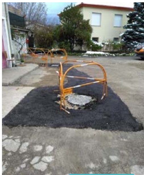
Création d'un regard
