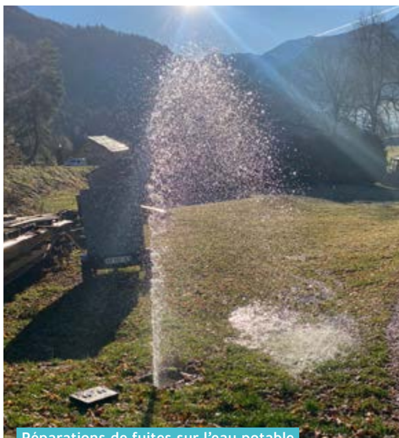
Réparations de fuites sur l'eau potable
