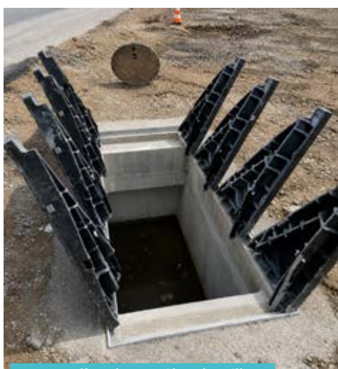
Trappe d'accès au piège à cailloux
