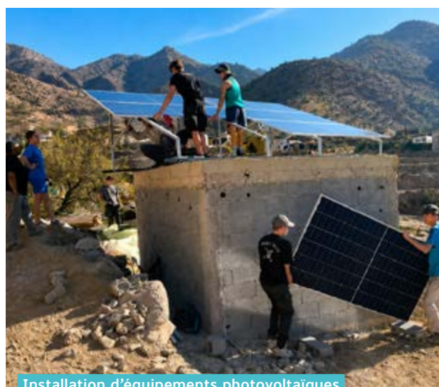
Installation d'équipements photovoltaïques
