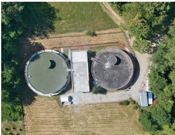
Réservoir de la Bataillarde : travaux sur les couvertures des cuves
