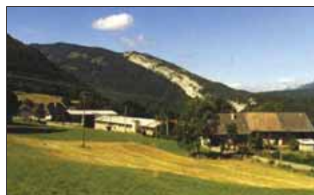
Ancienne scierie à démolir pour restructurer un nouveau quartier d'habitation
