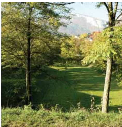
Bassin de rétention de la Baya, réalisé après l'évènement pluvieux du 26 mai 1986, pour tamponner les débits générés. Capacité d'environ 20 000 m 3 pour faire face à des évènements d'occurrence décennale.
