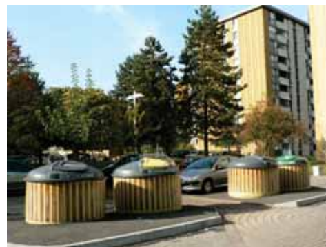
CGV semi enterrés mis en place au niveau du Clos Gaillard
