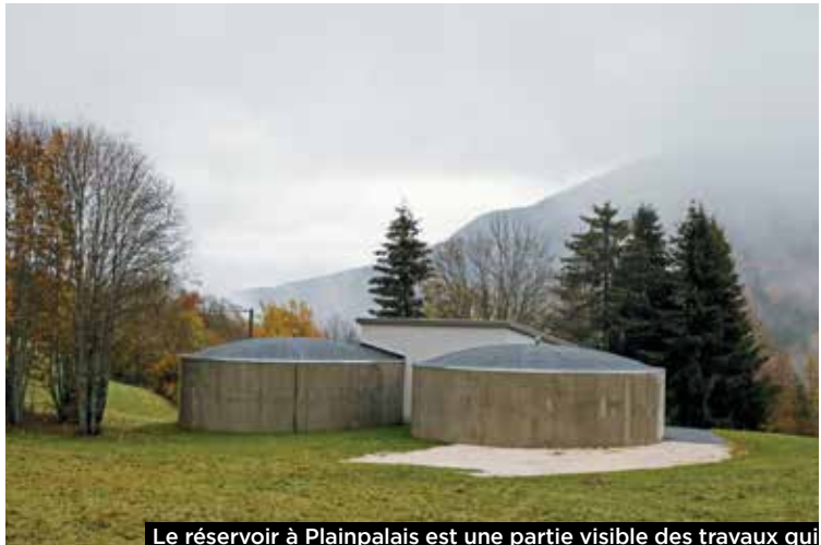
Le réservoir à Plainpalais est une partie visible des travaux qui permettent désormais d'alimenter Arith, Le Noyer, Les Déserts et St-François-de-Sales depuis St-Jean-d'Arvey en cas de pénurie d'eau.
