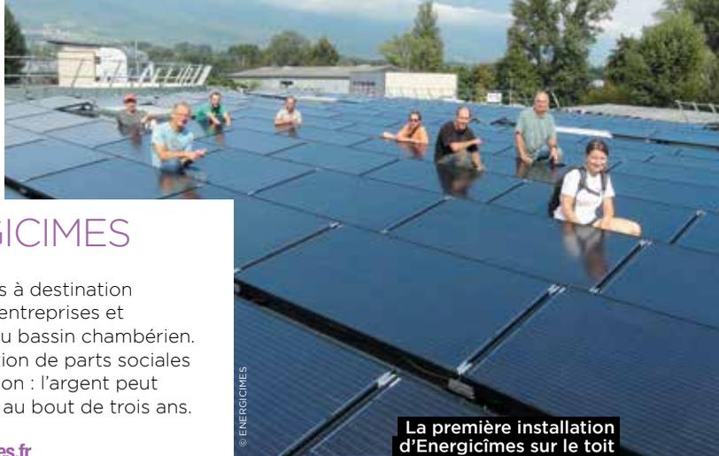
La première installation d'EnergiCimes sur le toit d'Emmaüs à La Motte-Servolex comprend 400 m<sup>2</sup> de modules.
